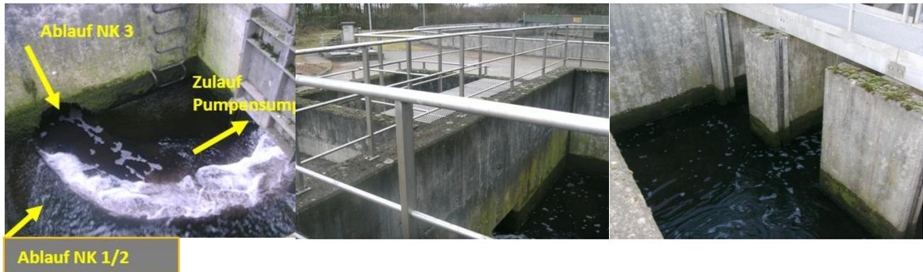
**Bild 22: Zulaufschacht und Pumpensumpf des Schneckenhebewerkes der Filtration**
