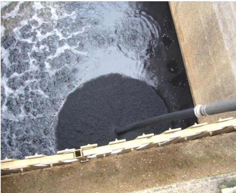
Abbildung 25: Verbandsklärwerk Obere Lutter – Füllung der Filterzelle mit granulierter Aktivkohle
