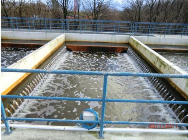
Abbildung 12: Filterzelle mit Zulauf über seitliche Überfallkanten
