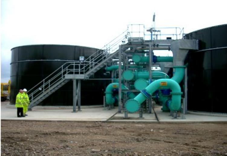
Abbildung 22: Großbritannien – Kläranlage Swindon, Einsatz von granulierter Aktivkohle
