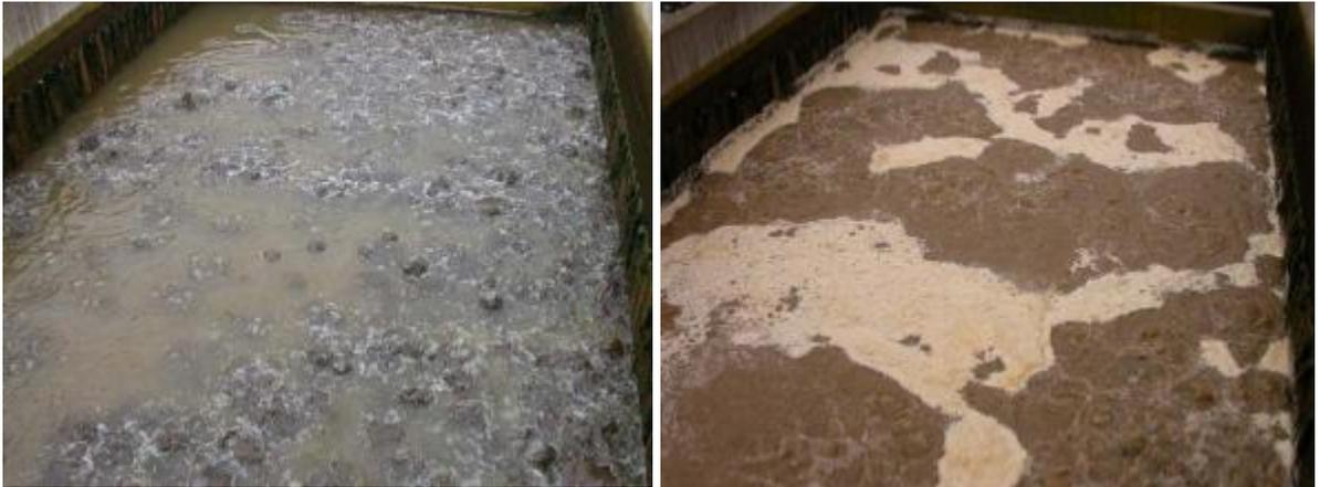
Abbildung 9: Spülbild eines sanierten Filters zu Beginn der Luftspülu (Quelle: EVERS ENGINEERUNG)
