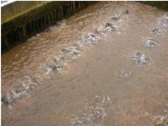
Abbildung 8: Spülbild eines Filters zu Beginn der Luftspülung
