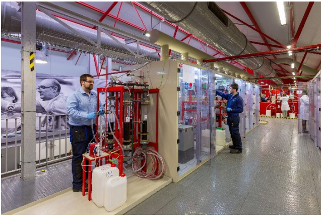
Pilotierung des Phos4Life-Verfahrens. Quelle: Técnicas Reunidas, José Lladó Technology Centre, Madrid
