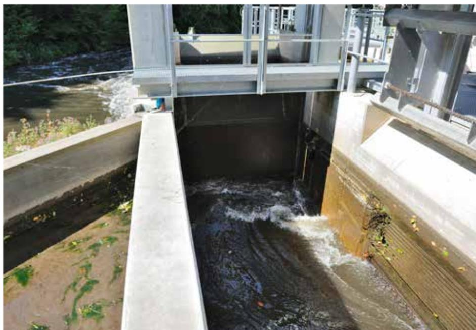
Abb. 8: Hydraulische Situation am Spülschütz vor dem Leerschuss (oben) und Aufsicht auf die Sogströmung bei Öffnung des Spülschützes (unten). Graphik: K. Bensing / TU Darmstadt, Foto: Institut für angewandte Ökologie GmbH
