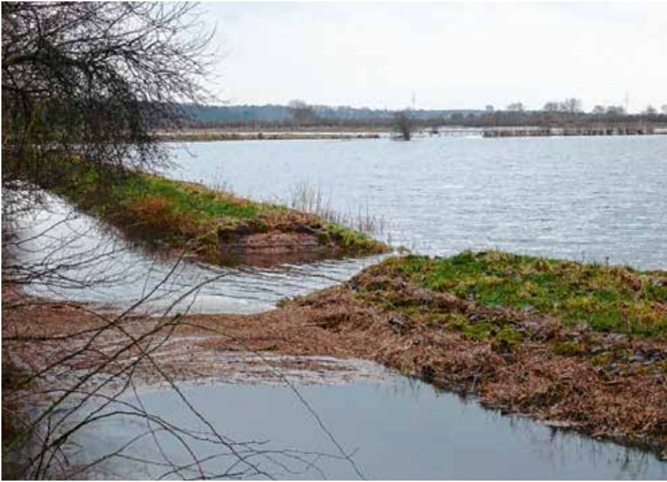
Abb. 4: Deichbruch nach Bisamtätigkeit
