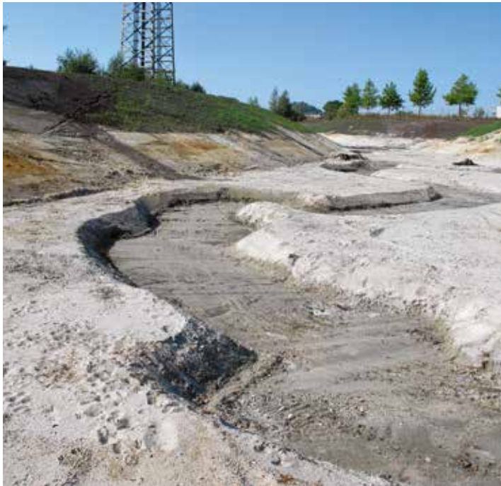
Abb. 1: 2016, unmittelbar nach der Geländemodellierung des Lämpkes Mühlenbachs Foto: G. Jacobs
