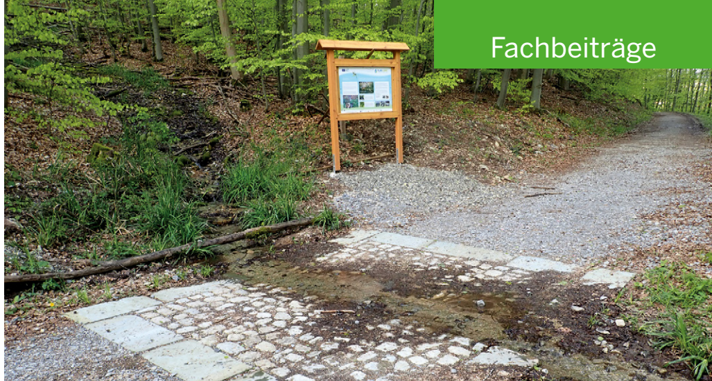
Abb. 12: An Quellgerinnen auf stärker befahrenen Forstwegen wurden einige befestigte (im Bild), sonst überwiegend unbefestigte Furten angelegt. Foto: Robert Behnke
