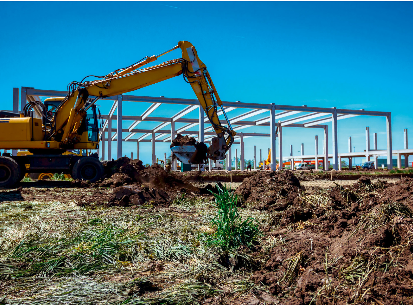
Abb. 1: Baggerarbeiten auf einer Baustelle. Foto: Adobe Stock / Roman_23203
