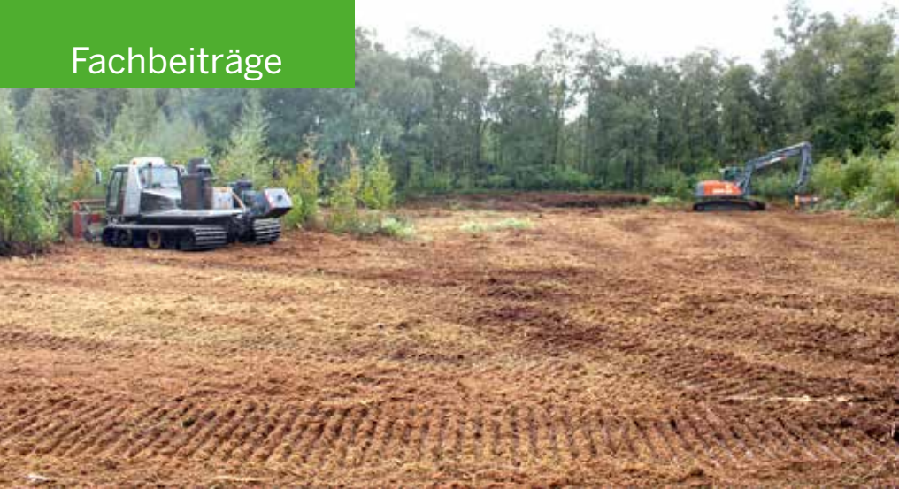
Abb. 2: Im Weißen Moor werden im Rahmen des IP-LIFE „Atlantische Sandlandschaften“ derzeit umfangreiche Renaturierungsmaßnahmen, wie beispielsweise das großflächige Entkusseln der zentralen Moorfläche, durchgeführt. Foto: Tim-Martin Wertebach
