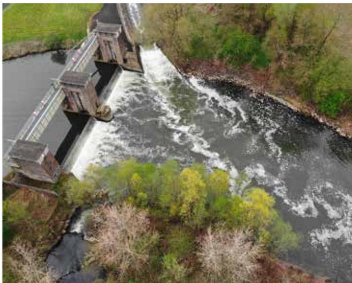
Abb. 10: Wehr Buddenburg, unten links im Bild ist der Einstieg in den naturnahen Fischaufstieg zu sehen, die Kühlwassereinleitung oben im Bild war im Untersuchungszeitraum bereits abgeschaltet und stellte somit keine Konkurrenzströmung dar. Foto: Landesfischereiverband Westfalen und Lippe e.V.
