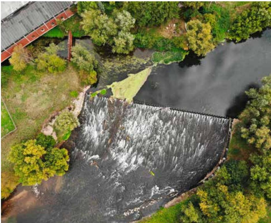
Abb. 8: Wehr Dahl, das unterste Wehr der Lippe, verfügt über einen nicht funktionierenden Fischaufstieg (rechts im Bild). Foto: Landesfischereiverband Westfalen und Lippe e.V.
