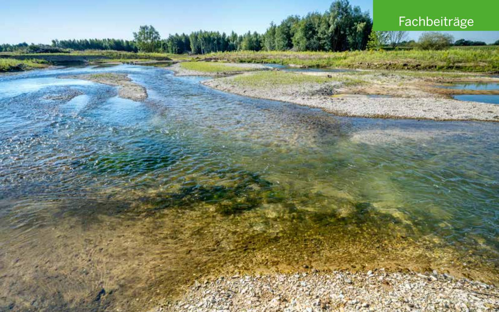
Abb. 14: Teilfläche der Renaturierung mit eigendynamisch entstandenen Kiesbänken, Pools und Riffelstrukturen sowie einer bemerkenswerten Strömungsvielfalt. Foto: Günter Bockwinkel
