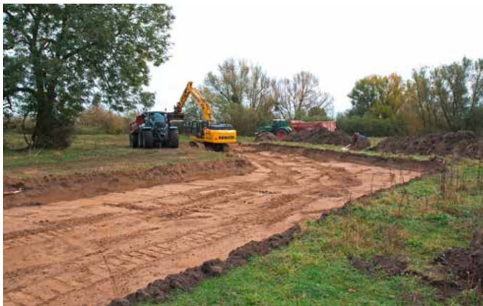
Abb. 7: Herstellung einer Rinne in der Meermersch. Foto: Birgit Beckers
