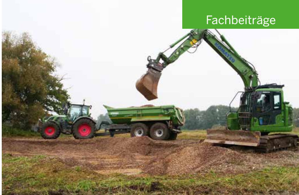
Abb. 12: Eine Kiesaufschüttung wird mithilfe eines Baggers im Steinhorster Becken entfernt. Foto: Birte Brever
