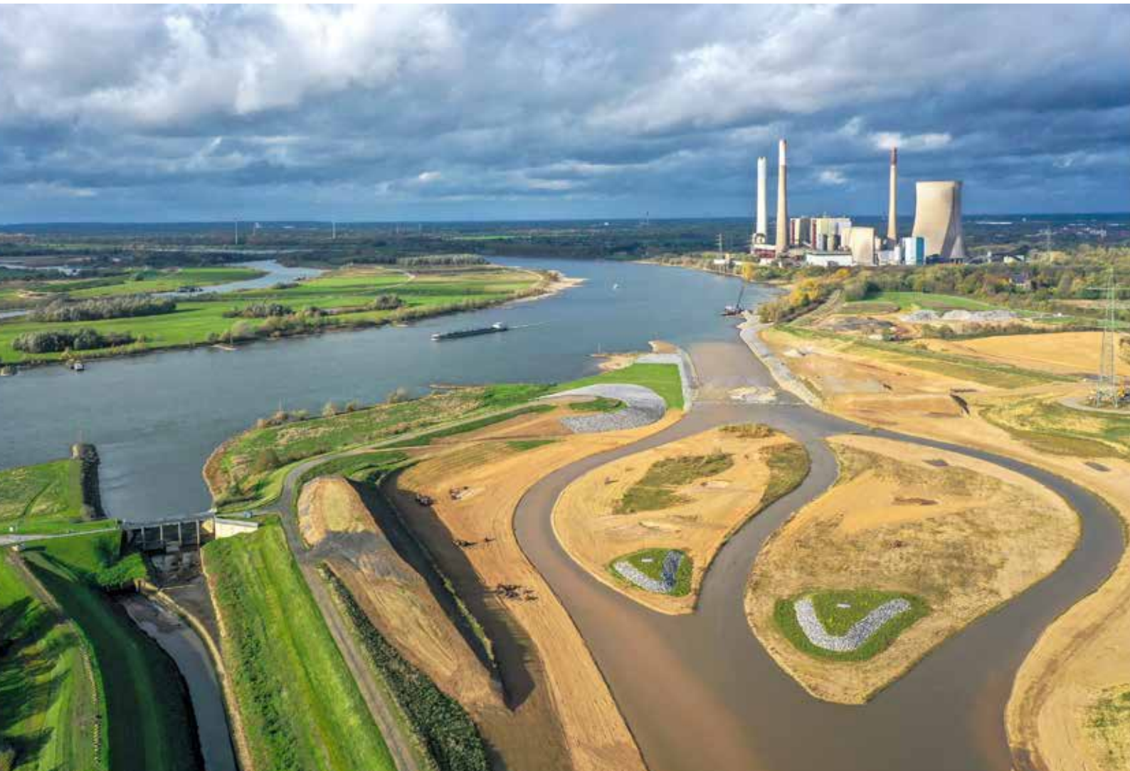
Abb. 1: Die neu angelegte Mündung der Emscher in den Rhein (rechts) und das alte Absturzbauwerk (links). Foto: EGLV
