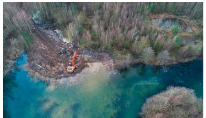
Ökologische Aufwertung: Die Schaffung von Flachwasserzonen steigerte die Fischbestände der in einer Studie untersuchten Seen nachhaltig. Foto: Thomas Klefoth
