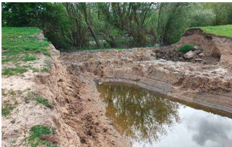
Abb. 8: Die Öffnung der Lippeverwallung kurz vor dem Durchstich in die Lippe. Foto: Birgit Beckers
