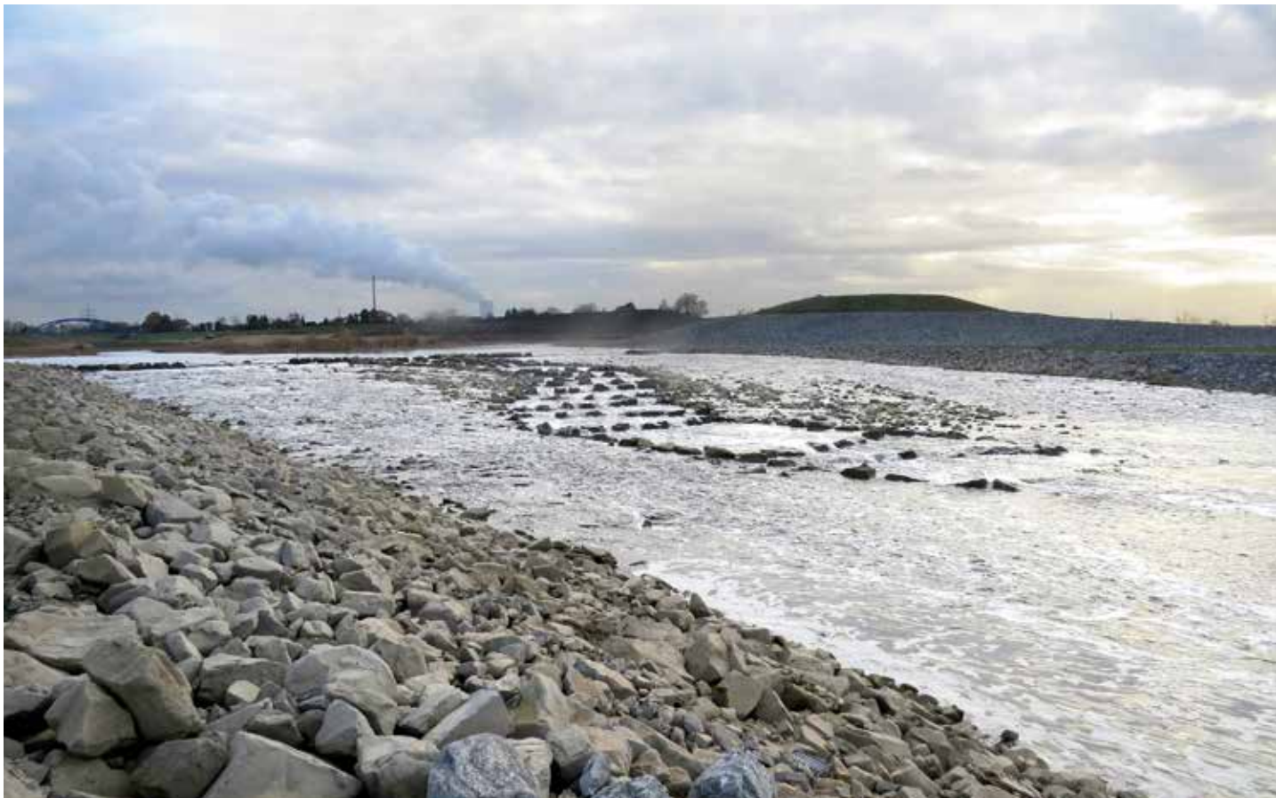
Abb. 4: Sohlgleitenskaskade von der Emscher zum Rhein. Foto: EGLV
