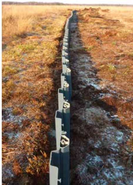
Abb. 2: Im Rahmen des IP-LIFE wurden zur Wiedervernässung und Renaturierung des Lebensraumtyps „Noch renaturierungsfähige degradierte Hochmoore“ (LRT 7120) im Oppenweher Moor Spundwände errichtet. Foto: Thorsten Obracay
