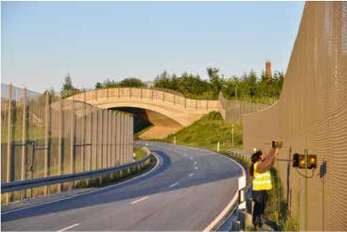
Abb. 3: Hohe Schutzzäune leiten die Fledermäuse entlang der Straße zu einer Grünbrücke, über die sie die Straße gefahrlos überqueren können. Mithilfe von „Batcordern“ wird überprüft, ob die Leitstrukturen angenommen werden und die Fledermäuse an dieser Stelle die Straße nicht mehr überqueren
