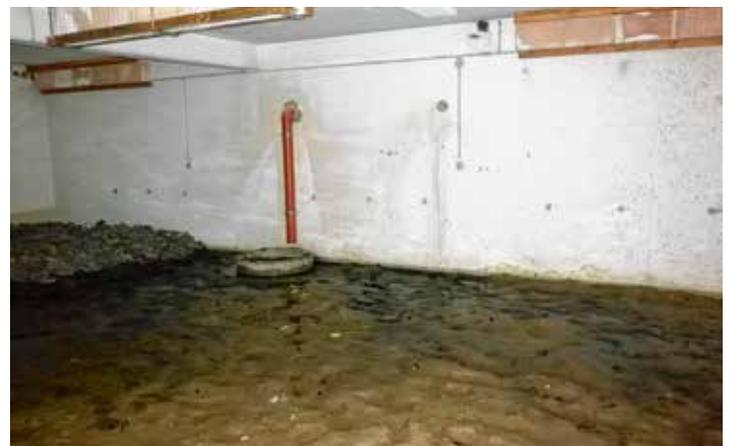
Abb. 4: Für optimale klimatische Bedingungen wurde der Kellerboden mit Sand bedeckt und Regenwasser vom Dach über Fallrohre in den Keller eingeleitet. An der Decke sind gut erkennbar mehrere Fledermausquartiere aus Hohlblockstein-Gruppen angebracht. Foto: Echolot GbR/S. Pawlik
