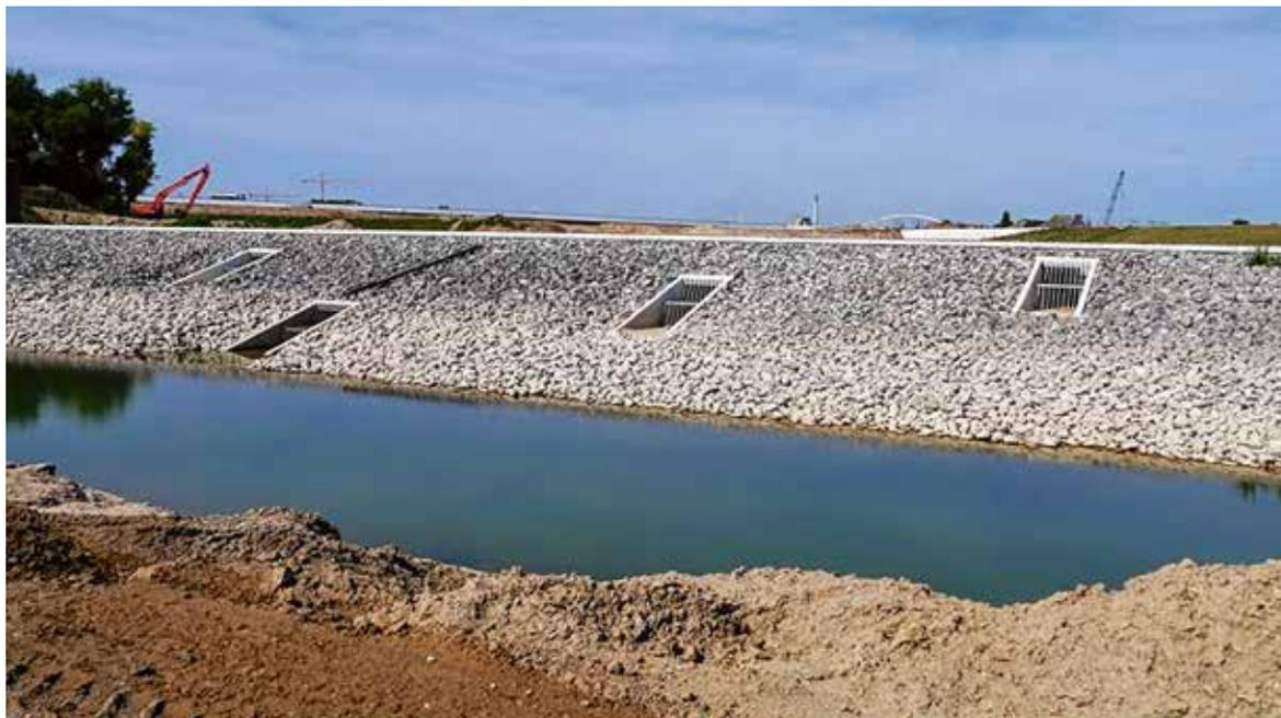
Abb. 3: Eine moderne Einlaufschwelle mit mehreren Dükern in unterschiedlichen Höhen: So kann die Nebenrinne ganzjährig durchströmt werden, ohne dass die Schifffahrt gefährdet wird
