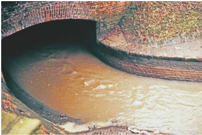
Abb. 2: Die Emscher in Dortmund Hörde 1985: Alle Abwässer wurden unterirdisch unter der Hermannshütte (heute Phoenix-See) hindurchgeführt und in einer von Sohlschalen ausgekleideten Rinne weitergeführt Foto: B. Stemmer
