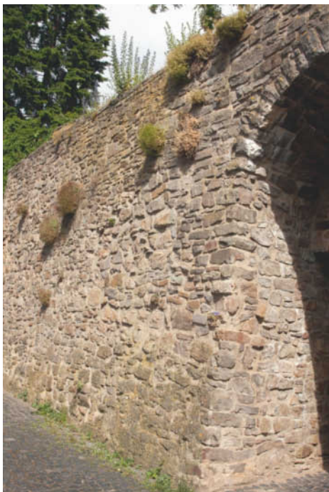
Abb. 5: Bei einer Sanierung von Mauern können Vegetationsstrukturen mit Ausnahme von im Mauerwerk wurzelnden Gehölzen erhalten bleiben
