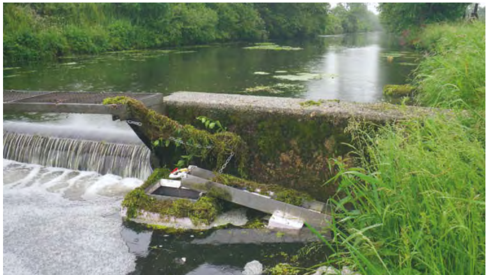
Abb. 6: Neue, getarnte Steigaalrinne an der Großen Wässerung
