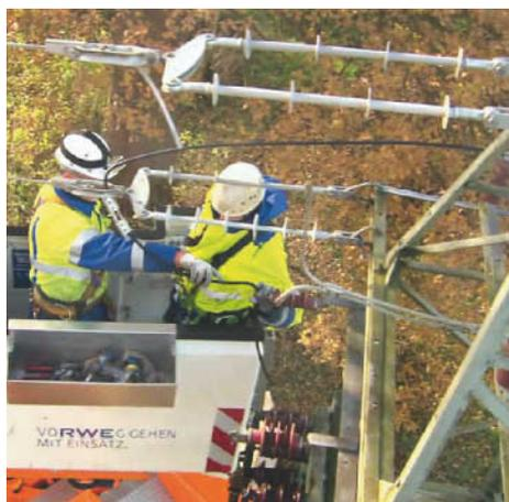
Montage von Langstabilisolatoren mithilfe einer Hubarbeitsbühne.
