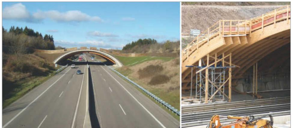
Grünbrücke „Heinzenberg“ (A1) kurz vor der Öffnung (links). Rechts Detail der tragenden Holzkonstruktion der Grünbrücke. Fotos: K.-H. Lorbach, M. Bauckloh
