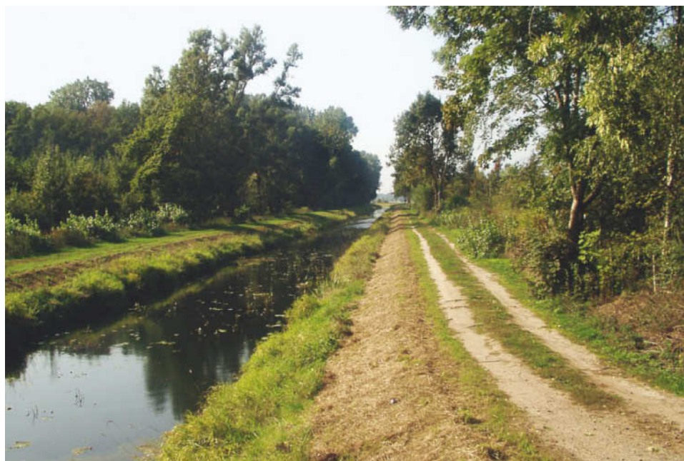
Abb. 2: Begradigtes und eingetieftes Gewässerprofil der Großen Aue. Foto: BUGEFI
