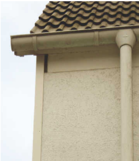
Abb. 2: Potenzielle Einfluglöcher, die im Zuge einer Wärmedämmung verloren gehen. Foto: F. Cassese
