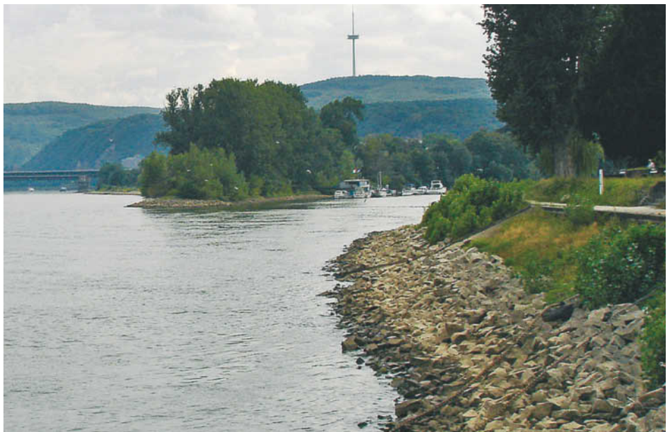
Normierte Flussbetten mit Blockwurf als Ufersicherung fördern die Etablierung und Ausbreitung gebietsfremder Arten. Foto: S. Nehring
