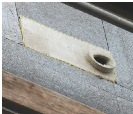
Im DBU-geförderten Projekt wurden Niststeine entwickelt, die in die neue Wärmedämmung integriert werden können, im Bild ein Einbaustein für Mauersegler.
