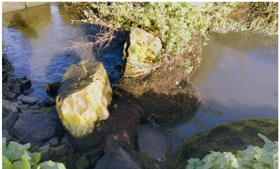
Abb. 2: Elodea -Polster versperren die Durchlässe zwischen den Steinquerriegeln des Raugerinnes im Fischaufstieg Harkortsee und verhindern damit die Durchgängigkeit für Fische. Foto: Ruhrverband
