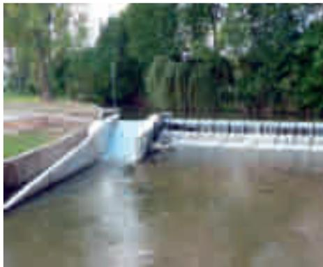
*Wasserkraftanlage Bad Sulza: Die neue Kraftanlage unter Wasser am Ilmwehr im Kurpark von Bad Sulza. Trotz der geringen Fallhöhe des Wassers kann hier Energie gewonnen werden. Links ist der Fischpass, der der Wanderweg für Fische, zu sehen.*
