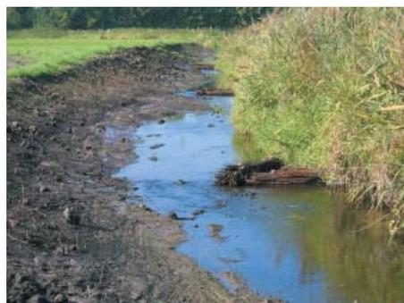
Abb. 3: Strömungslenker
