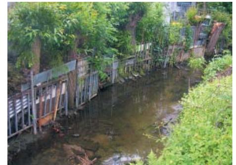
Abb. 11: Naturferne Ufersicherung / Eingengung des Bachprofils
