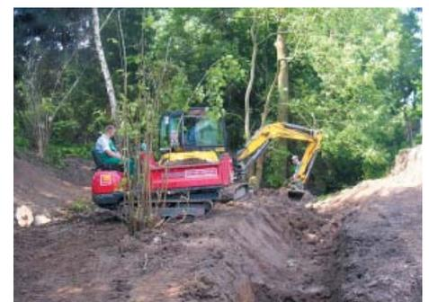
Abb. 12: Einsatz von Minibagger und Raupenkipper
