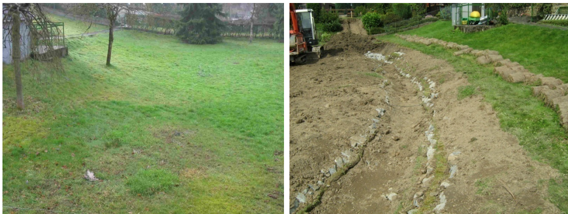
Abb. 5: Rückbau einer Verrohrung an einem kleinen Talauebach des Grundgebirges; links vor der Maßnahme und rechts während der Bauphase (Blick in Fließrichtung) (Fotos: Aggerverband)
