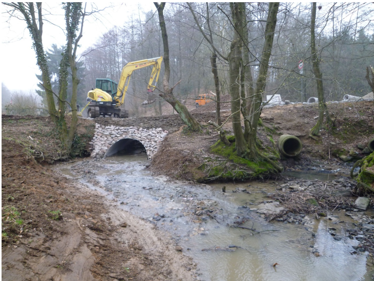
Abb. 10: Ersatzneubau eines durchgängigen Durchlasses/Brücke an einem kleinen Talauebach des Deckgebirges (Murbach): der Rohrdurchlass mit anschließendem Absturz (rechte Bildhälfte) wurde durch einen sohldurchgängigen Durchlass ersetzt (Fotos: Wupperverband)
