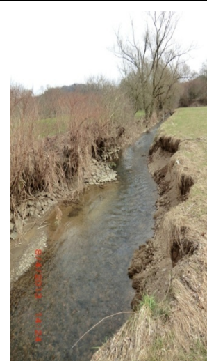
Abb. 31: Rückbau Uferverbau am Naafbach; links: historischer Ausbauzustand; mittig: während der Bauphase; rechts: nach der Entnahme (Fotos: Aggerverband)
