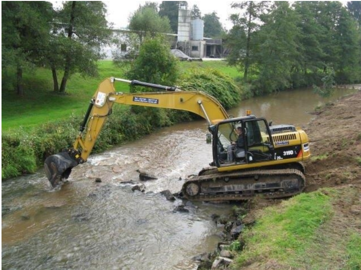
Abb. 25: Rückbau Sohlverbau an einem schottergeprägten Fluss des Grundgebirges (Foto: Aggerverband)
