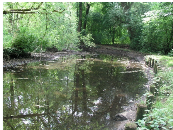
Abb. 34: Bereits stark verfallener nicht mineralischer Uferverbau ehemals bestehend aus Faschinen und den heute noch sichtbaren Pfahlreihen an einem organisch geprägten Tieflandsbach (Fotos: PBK)
