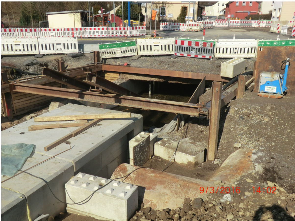
Abb. 6: Ersatzneubau einer durchgängigen Verrohrung/Überbauung an einem kleinen Talauebach des Grundgebirges (Rospebach in Vollmershausen) (Foto: Aggerverband)
