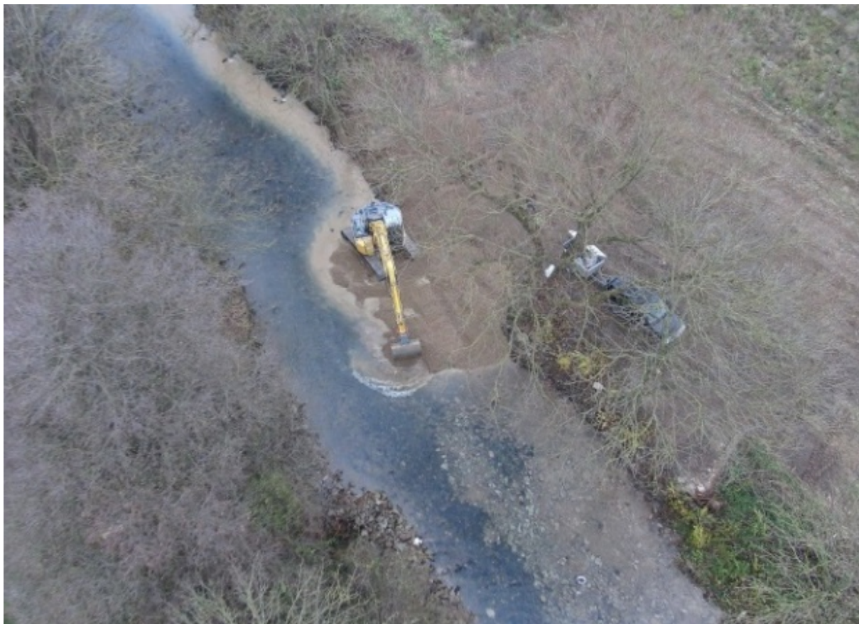
Abb. 16: Geschiebezugabe in einen schottergeprägten Karstfluss: während der Bauphase (Multikopteraufnahme: PBK)
