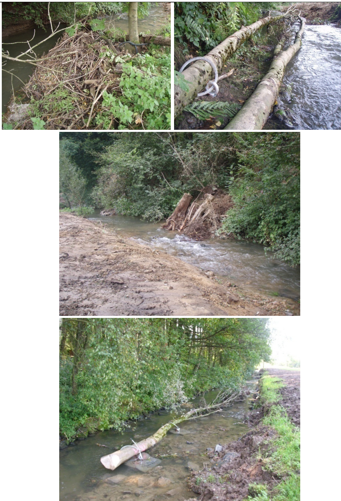
Abb. 27: Einbau von gesichertem Totholz als Initialmaßnahme zur Sohlstrukturierung an einem großen Talauebach des Deckgebirges (Waldbrölbach bei Berkenroth) (Fotos: Aggerverband)
