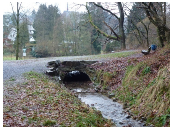
Abb. 8: Ersatzneubau eines Durchlasses/Brücke an der Deipenbecke; links und rechts oben: Vorzustand. rechts unten: nach Umsetzung: der verrohrte Durchlass wurde verkürzt sowie ein 80 cm hoher Absturz im Innern beseitigt und Sediment eingebracht (Fotos: Wupperverband)
