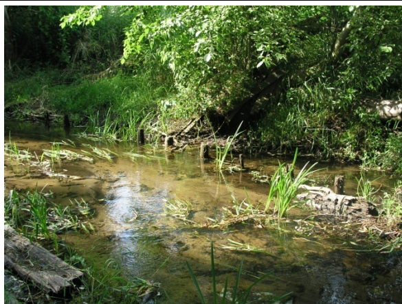
Abb. 34: Bereits stark verfallener nicht mineralischer Uferverbau ehemals bestehend aus Faschinen und den heute noch sichtbaren Pfahlreihen an einem organisch geprägten Tieflandsbach (Fotos: PBK)
