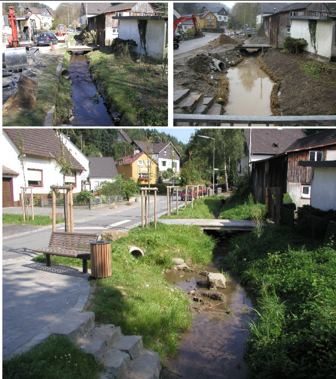
Abb. 30: Erhöhung Vielfalt Uferstruktur in Restriktionsbereichen an einem kleinen Taluebach des Grundgebirges (Hesselbach) (Fotos: Aggerverband)
