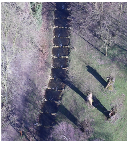
Abb. 28: Rückbau eines kleinen Absturzes im Bereich einer Grünanlage (oben) und Anlage einer rauen Gleite in Riegelbauweise zur Sohlstützung (Fotos: PBK)
