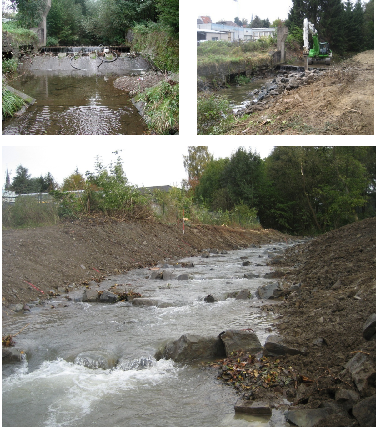
Abb. 12: Rückbau einer Wehranlage an einem kleinen Talauebach des Grundgebirges und Umbau zur rauen Gleite (Dörspe in Bergneustadt); oben links und rechts: vor und während der Bauphase; unten: nach Abschluss der Bauarbeiten (Fotos: Aggerverband)
