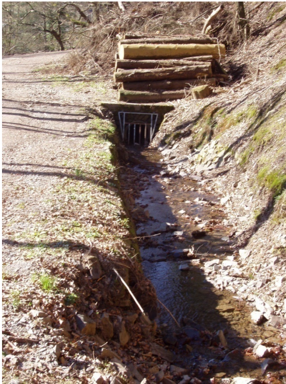
Abb. 8: Ersatzneubau eines Durchlasses/Brücke an der Deipenbecke; links und rechts oben: Vorzustand. rechts unten: nach Umsetzung: der verrohrte Durchlass wurde verkürzt sowie ein 80 cm hoher Absturz im Innern beseitigt und Sediment eingebracht (Fotos: Wupperverband)
