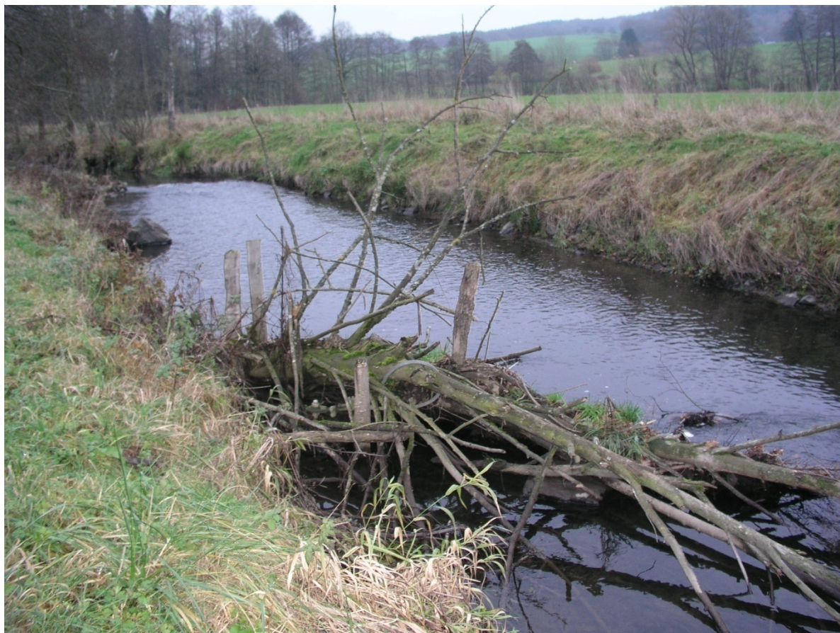
Abb. 21: Profilentwicklung durch gesicherten Totholzeinbau in der freien Landschaft an einem Tal-auebach des Deckgebirges zur Erhöhung der Vielfalt an Sohlstrukturen in Restriktionsbereichen – die angrenzenden Flächen stehen nicht für die Gewässerentwicklung zur Verfügung (Foto: PBK)
