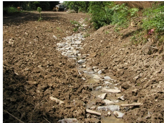
Abb. 29: Sohlstützung an einem kleinen Fließgewässer (Marienhagener Bach) (Fotos: Aggerverband)
