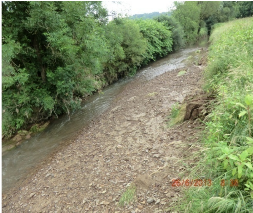
Abb. 32: Rückbau Uferverbau am Naafbach kurz oberhalb der Mündung in die Agger: nach der Entnahme (Foto: Aggerverband)
