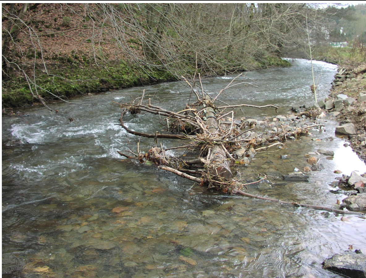
Abb. 26: Einbau von gesichertem Totholz als Initialmaßnahme zur Sohlstrukturierung an einem großen Talauebach des Deckgebirges (Foto: PBK)
