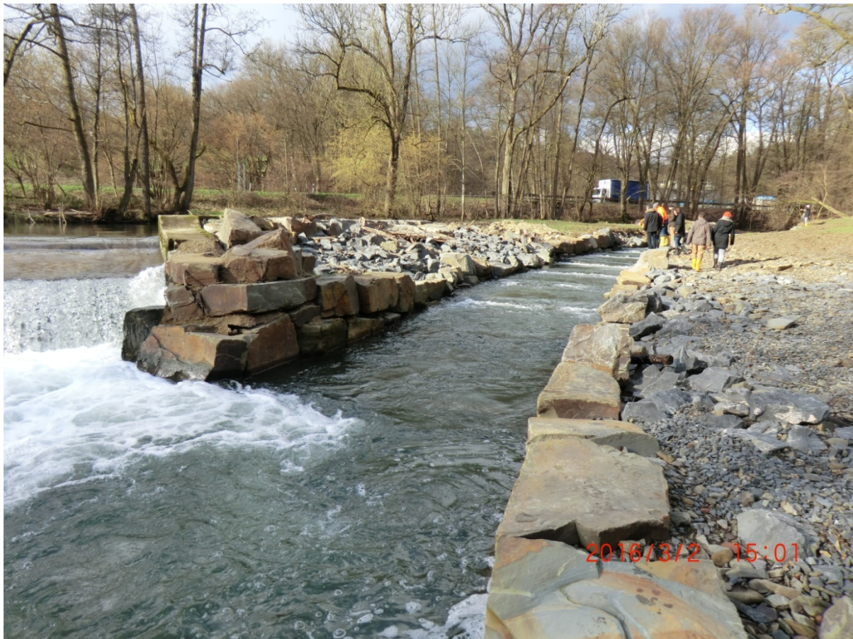
Abb. 14: Umgehungsgerinne an einem schottergeprägten Fluss des Grundgebirges: oben links: sanierungsbedürftiges Wehr vor Durchführung der Maßnahme; oben rechts: Umgehungsgerinne in Riegelbauweise während der Bauphase; unten: Einmündung des Umgehungsgerinne (Fotos: Aggerverband)
