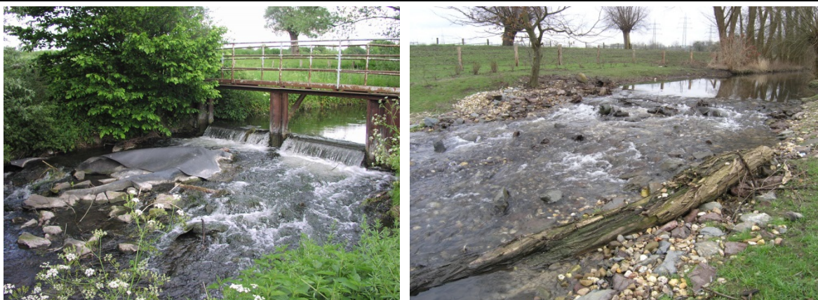
Abb. 11: Ehemaliger Kulturstau im Tiefland (links). Das Wehr wurde durch eine sehr flache und durchgängige Gleite ersetzt (rechts), da ansonsten das typkonforme Gefälle nicht realisiert werden konnte (Fotos: PBK)
