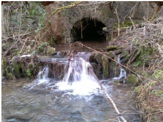
Abb. 43: Punktuelle Sohlanhebung zur Wiederherstellung der Durchgängigkeit unterhalb eines Durchlasses; links: vorher; rechts: nachher (Fotos: Aggerverband)
