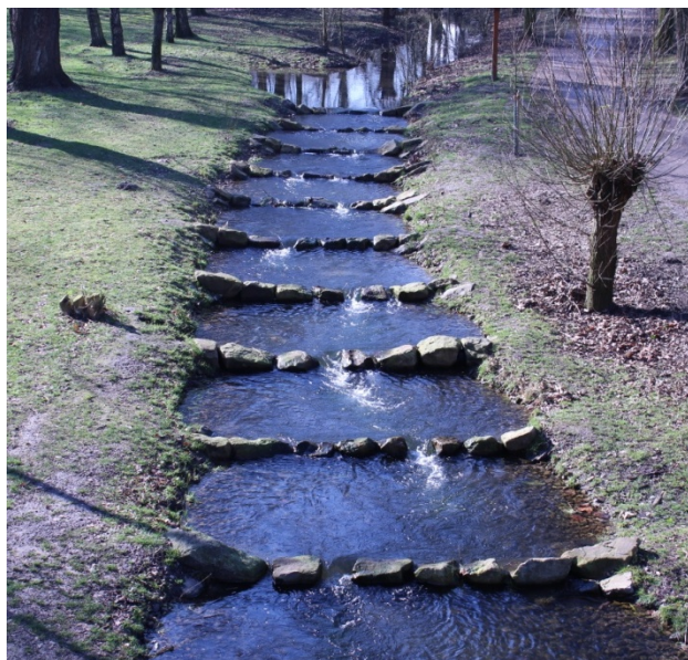
Abb. 28: Rückbau eines kleinen Absturzes im Bereich einer Grünanlage (oben) und Anlage einer rauen Gleite in Riegelbauweise zur Sohlstützung (Fotos: PBK)
