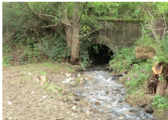
Abb. 43: Punktuelle Sohlanhebung zur Wiederherstellung der Durchgängigkeit unterhalb eines Durchlasses; links: vorher; rechts: nachher (Fotos: Aggerverband)
