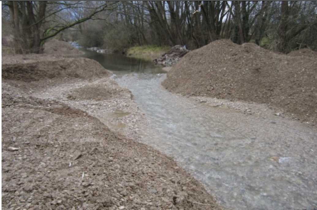
Abb. 17: Geschiebebezugabe in einen schottergeprägten Karstfluss: Situation nach Einbringung (Foto: S. Hasenclever – PBK)
