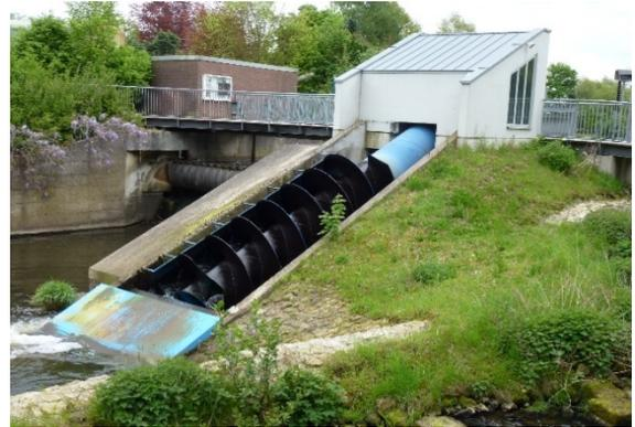
Wasserkraftanlage mit Wasserkraftschnecke
