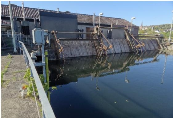
Wasserkraftanlage mit vorgeschalteter Rechenanlage
