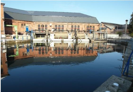
Wasserkraftanlage mit vorgeschalteter Rechenanlage
