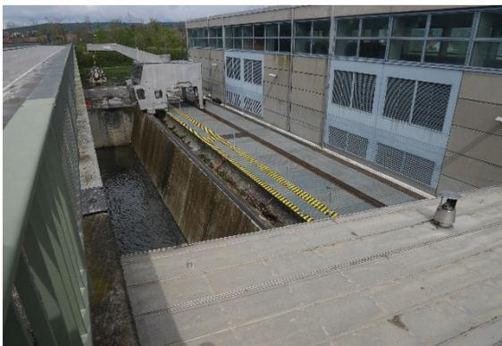
Wasserkraftanlage mit vorgeschalteter Rechenanlage
