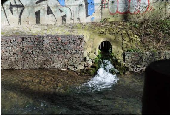
massiver Verbau: Steinsatz, unverfugt (Gabionen)
