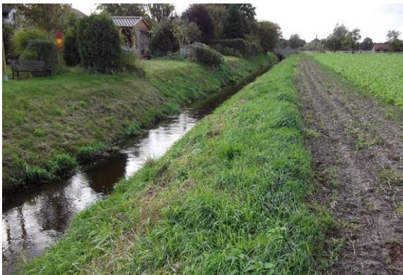
technisches Regelprofil (Trapezprofil)
