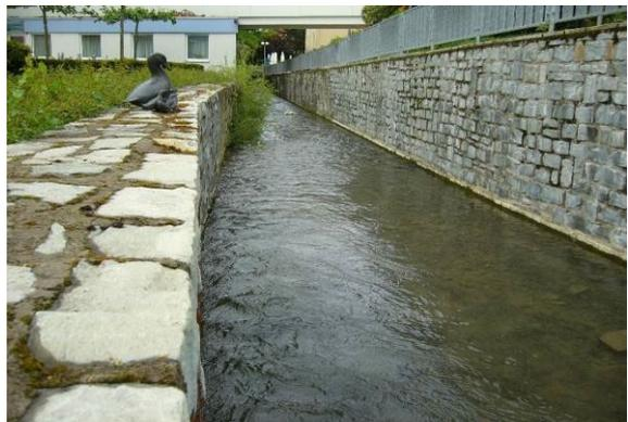
technisches Regelprofil (Kastenprofil)
