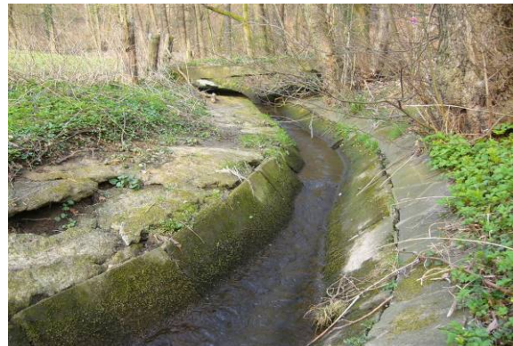
massiver Verbau: Beton
