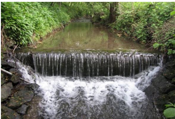
mittlerer Absturz 0,3 – 1 m
