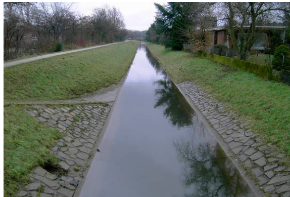
Massivsohle ohne Sediment
