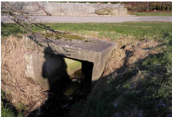
Verrohrung/Überbauung > 20 m, mit Sediment
