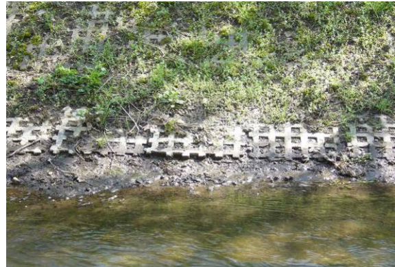
massiver Verbau: Gittersteine
