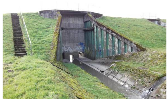
Durchlass, Lauf verengt, ohne Sediment (Durchfluss durch den Erdkörper eines HRB)
