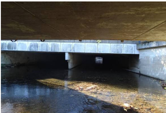
Verrohrung/Überbauung > 100 m, mit Sediment
