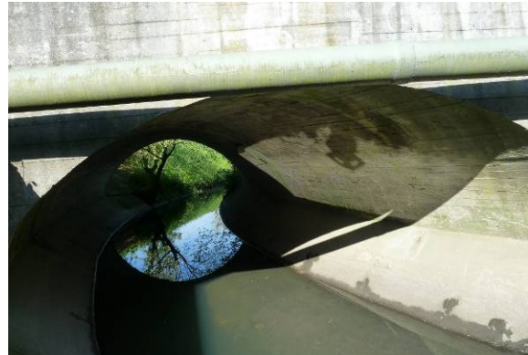
Verrohrung/Überbauung > 10 m, ohne Sediment
