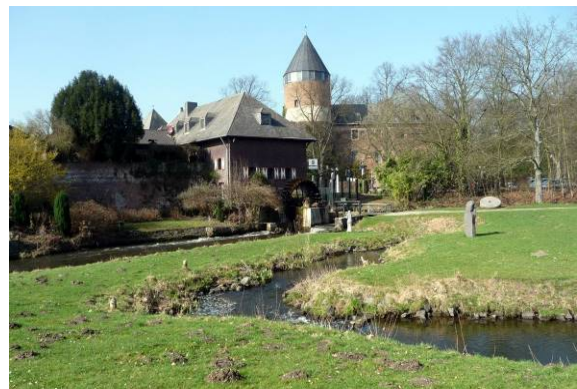
bewegliches Wehr > 1 m mit Umgehungsgerinne
