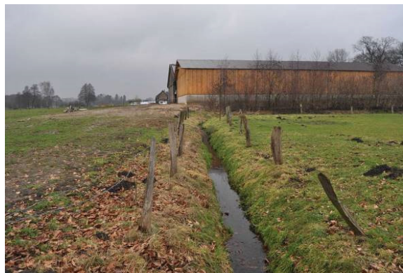
gewässerstrukturschädliche Anlagen: Gehöft, Einzelbauwerk
