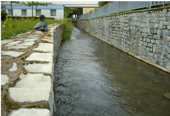
massiver Verbau: Mauerwerk (verfugt)
