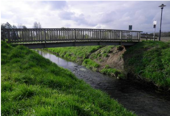
Brücke, strukturell nicht schädlich
