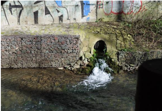
massiver Verbau: Steinsatz, unverfugt (Gabionen)
