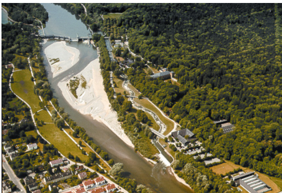
bewegliches Wehr > 1 m mit Umgehungsgerinne (rechts)
