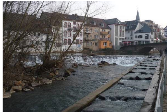
Absturz > 1 m mit Fischwanderhilfe (Fischterrasse)
