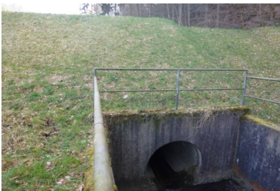
Verrohrung/Überbauung > 10 m, ohne Sediment (Durchfluss durch den Erdkörper eines HRB)
