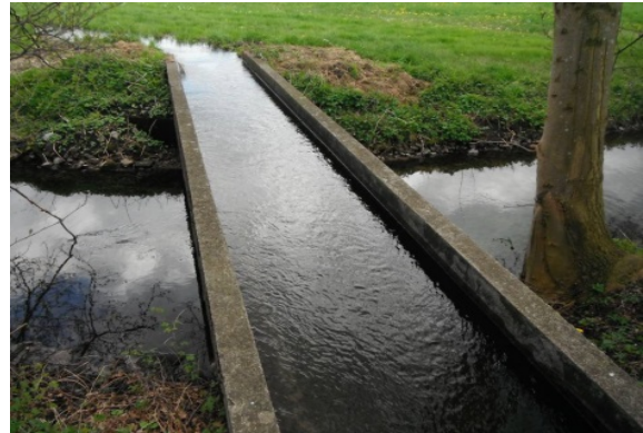
(Wasser)Brücke, strukturell nicht schädlich
