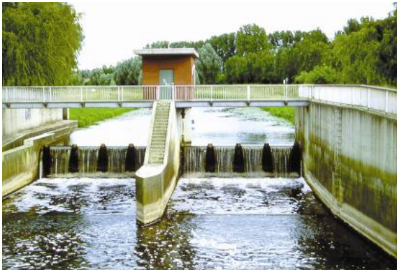
bewegliches Wehr > 1 m mit Fischwanderhilfe (links)
