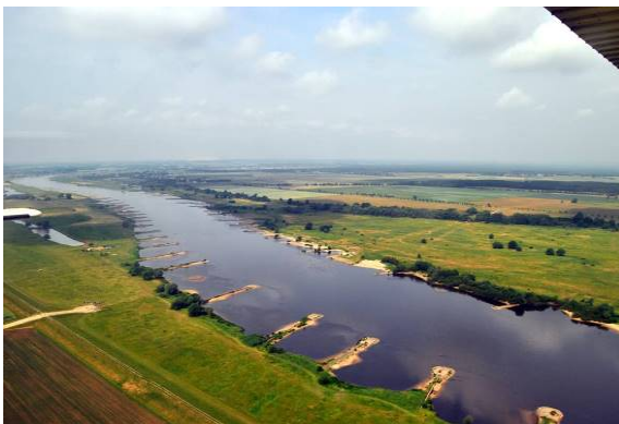
massiver Verbau: Buhnen
