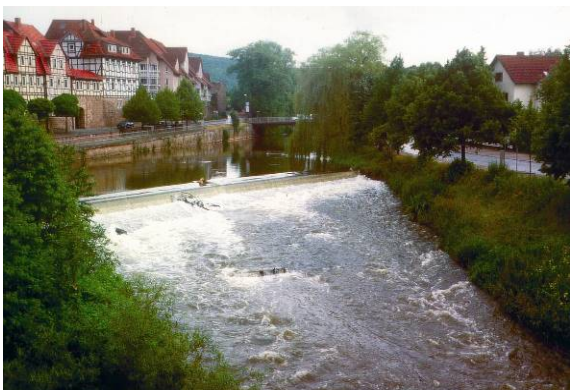
Absturz, unterhalb raue Rampe
