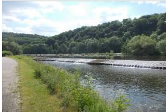
glatte Rampe (Streichwehr)
