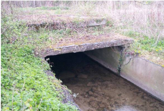
Verrohrung/Überbauung > 10 m, mit Sediment
