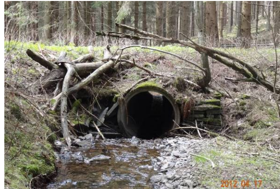
Durchlass, Lauf verengt, ohne Sediment
