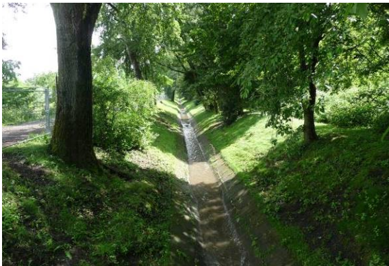
Massivsohle ohne Sediment
