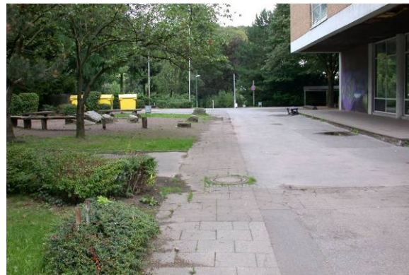
Verrohrung/Überbauung > 250 m, nicht erkennbar
