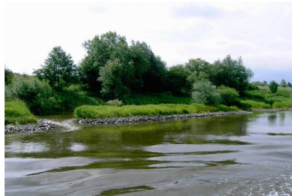
massiver Verbau: Leitwerk
