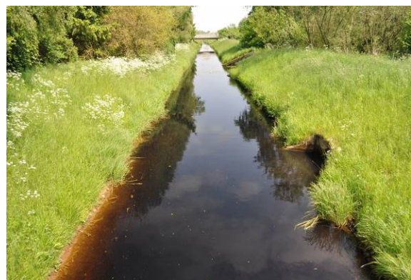
Sohle nicht erkennbar
