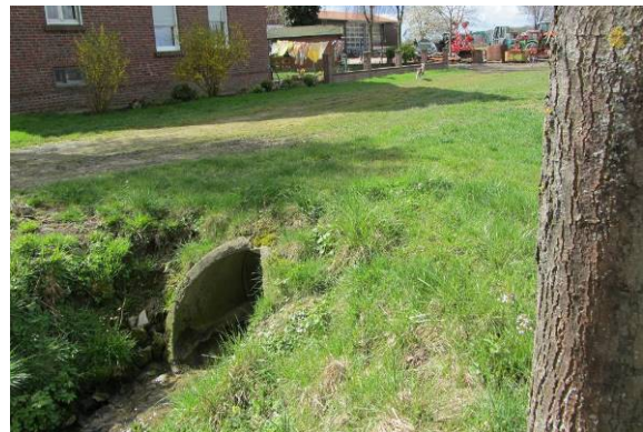
Verrohrung/Überbauung > 20 m, ohne Sediment
