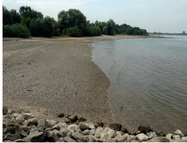
Abb. 7: Für den unteren Niederrhein typisch sind Bühnenfelder mit Flachufer und sandig-kiesigem Substrat
