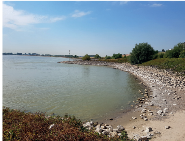
Abb. 8: Kleine Bühnenfelder mit steilem Ufer und Steinschüttung bieten kaum Raum für die Ausbildung von Uferstrukturen
