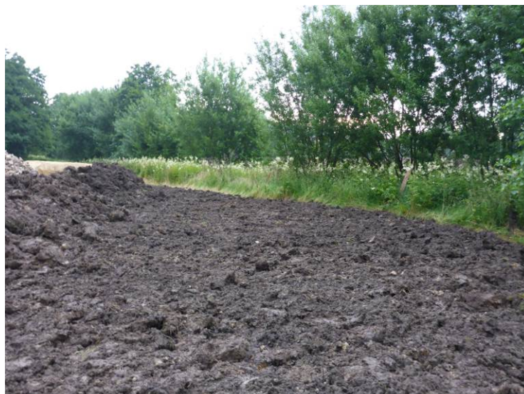
Foto: Aufgetragenes humusreiches Bodenmaterial
