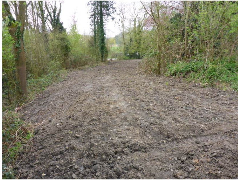
Rekultivierte Baustraße mit Blickrichtung Schloss-Rahe-Straße
