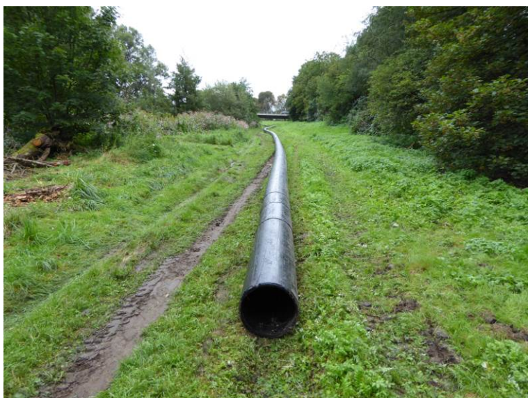
Verlegung des Bypass-Rohrs
