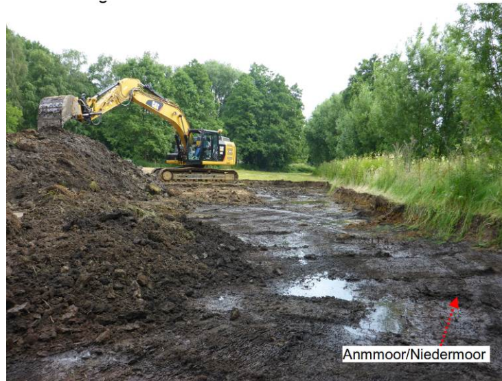
Freilegen der Anmoor-/Niedermoorschichten
