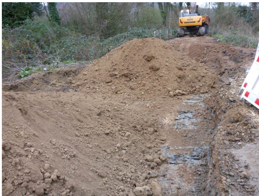
April 2016: Bereits zurückgebauter Baustraßenabschnitt mit angeschüttetem Unterbodenmaterial
