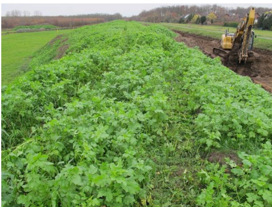
Dezember 2013: Verfüllung Flutkanal; Begrünung der Bodenmieten hat das Bodenmaterial trocken gehalten, so dass trotz des Winteranbruchs verfüllt werden konnte.
