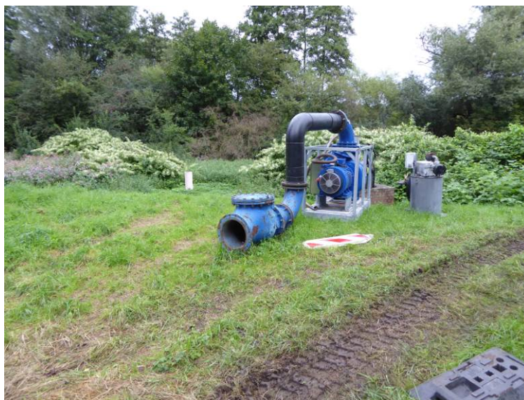
Aufstellen von Pumpen für Überleitung des Abwassers
