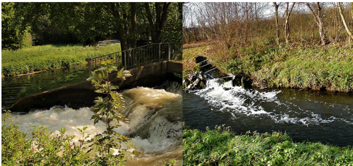
Abbildung 3: Einleitung von Sumpfungswasser (links) und Kläranlagenabwasser (rechts) in die Erft. Quelle: Erftverband.
