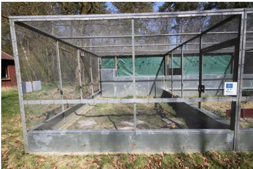
**Abbildung 5:** Erneuerung des Überkletterungsschutzes in 2015 durch Verwendung von gewinkelten Titanblechen (die normalerweise für den Hausdachbau eingesetzt werden), da die Vorgängerkonstruktion durch Verwerfungen nicht mehr durchschlupfsicher war (Foto: A. Geiger)
