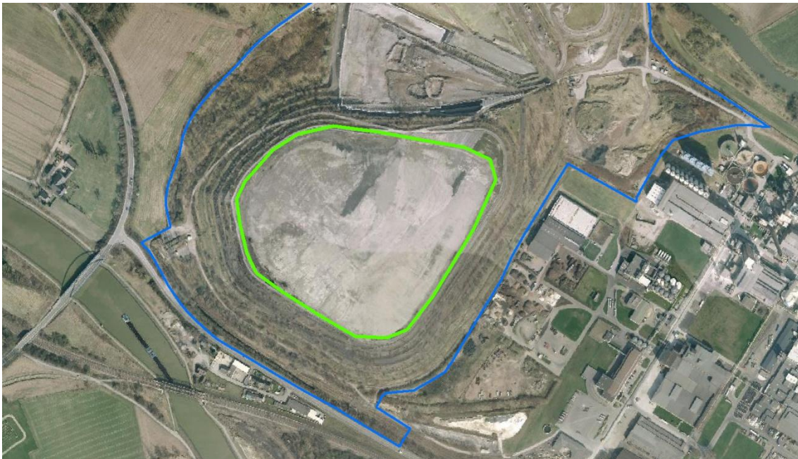
Abbildung 5.7: Fläche mit hohem Solarpotenzial auf einer Deponie (Luftbild: Geobasis.NRW)
