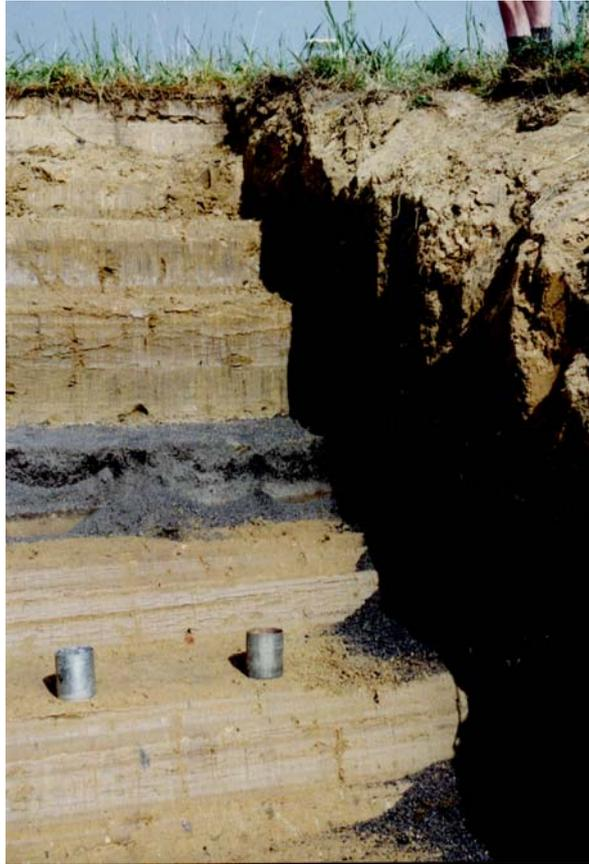
**Abbildung 3** Profil des Oberflächenabdichtungssystems mit 25 cm mächtiger Granulatschicht als Flächendränage Aufnahme im Sept. 2001, zwei Jahre nach dem Einbau
