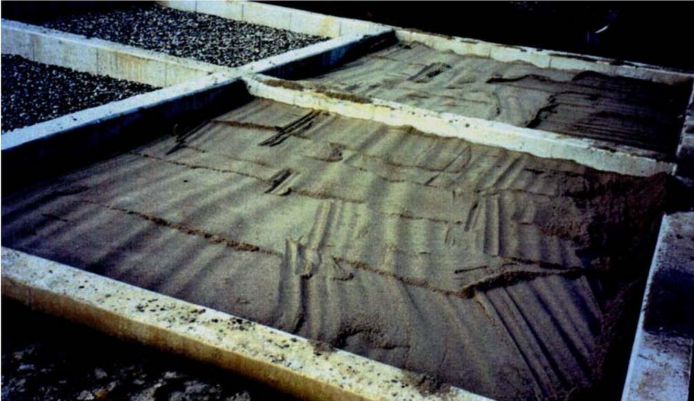
**Abbildung 2** Betonwanne mit Kies-Sandfüllung
