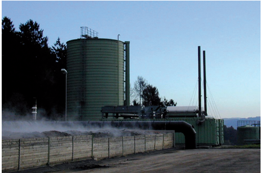
Biofilter vor Vergärungsanlage
