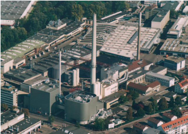
Biomassekraftwerk FUG, Ulm (Freigegeben von FUG, Ulm)
