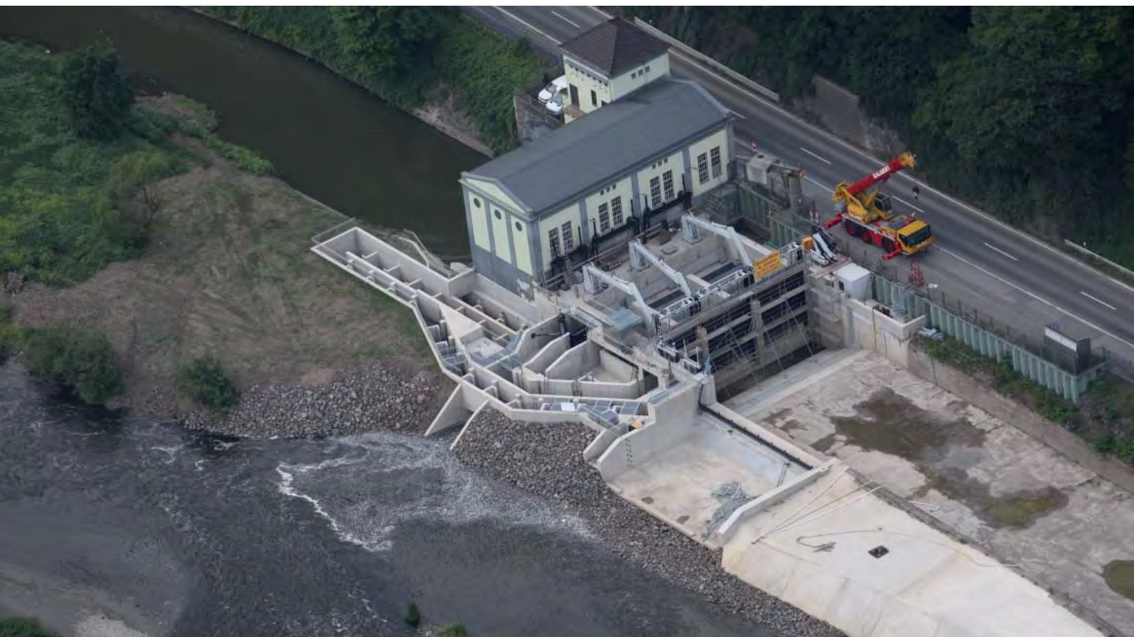
WKA Unkelmühle in der Umbauphase
