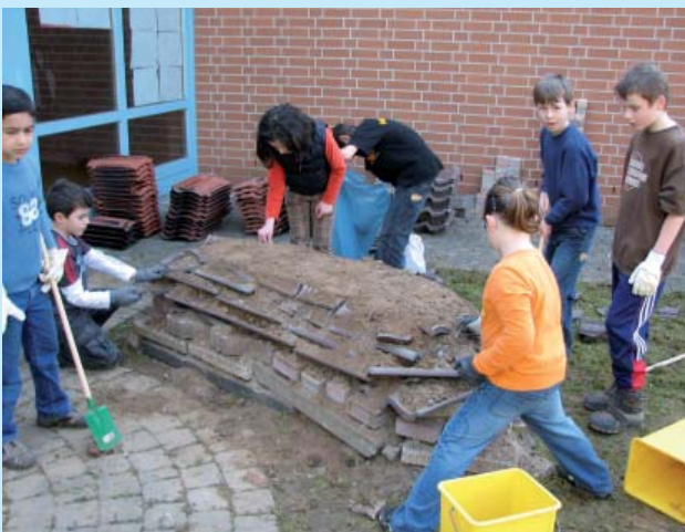
Naturnahe Umgestaltung des Schulgeländes an der Lindenschule in Krefeld: Bau einer Trockenmauer
