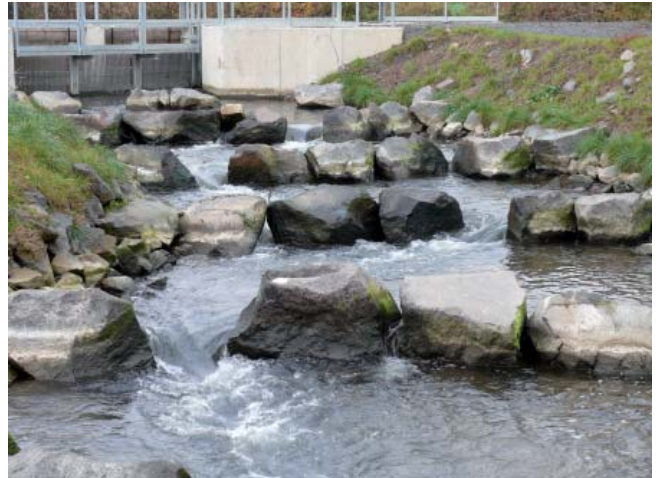
Fischtreppe an der Agger
