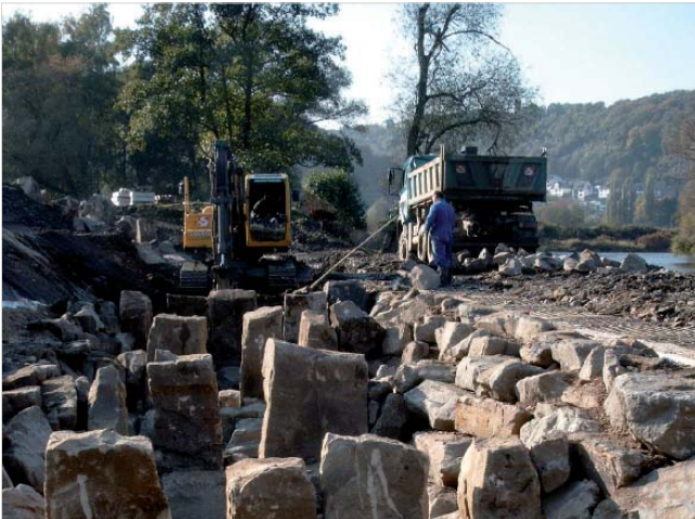
Bau einer Fischaufstiegshilfe
