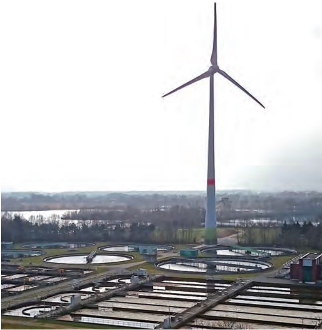
Windrad auf der Kläranlage Paderborn
