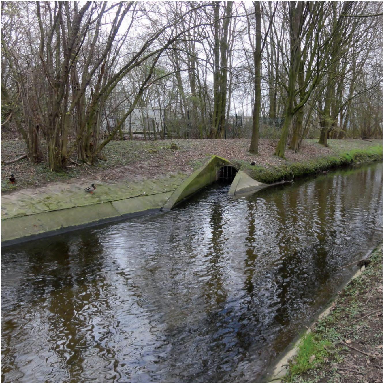
Abwassereinleitung in die Itter zwischen Düsseldorf und Hilden
