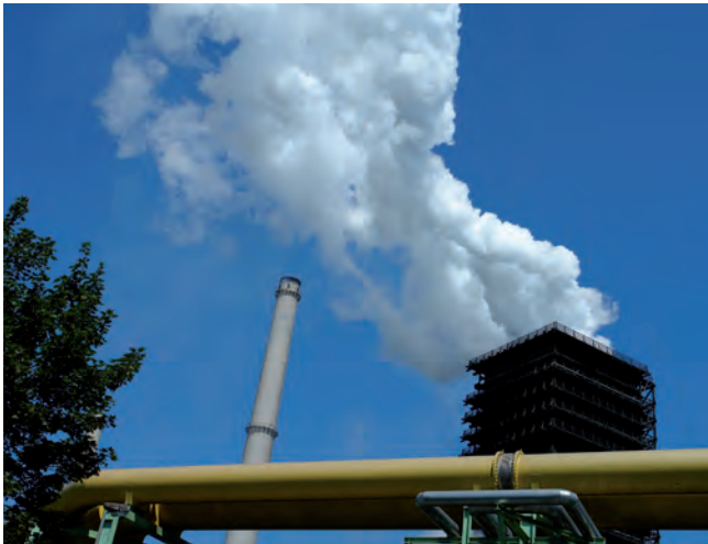
Hochofen ThyssenKrupp Duisburg
