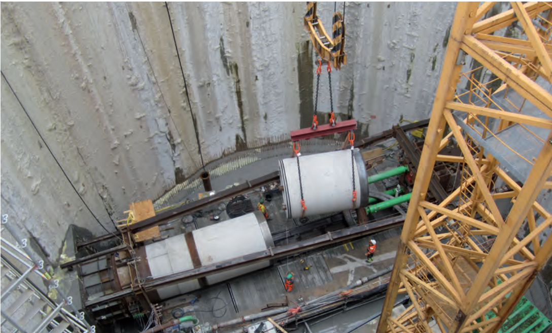
Kanal-Baustelle Abwasserkanal Emscher
