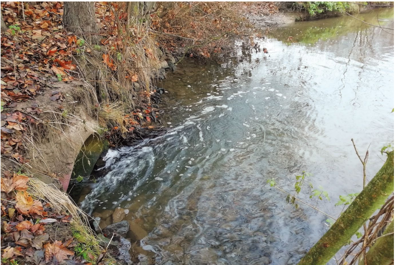
Einleitstelle der Kläranlage Enger in den Brandbach
