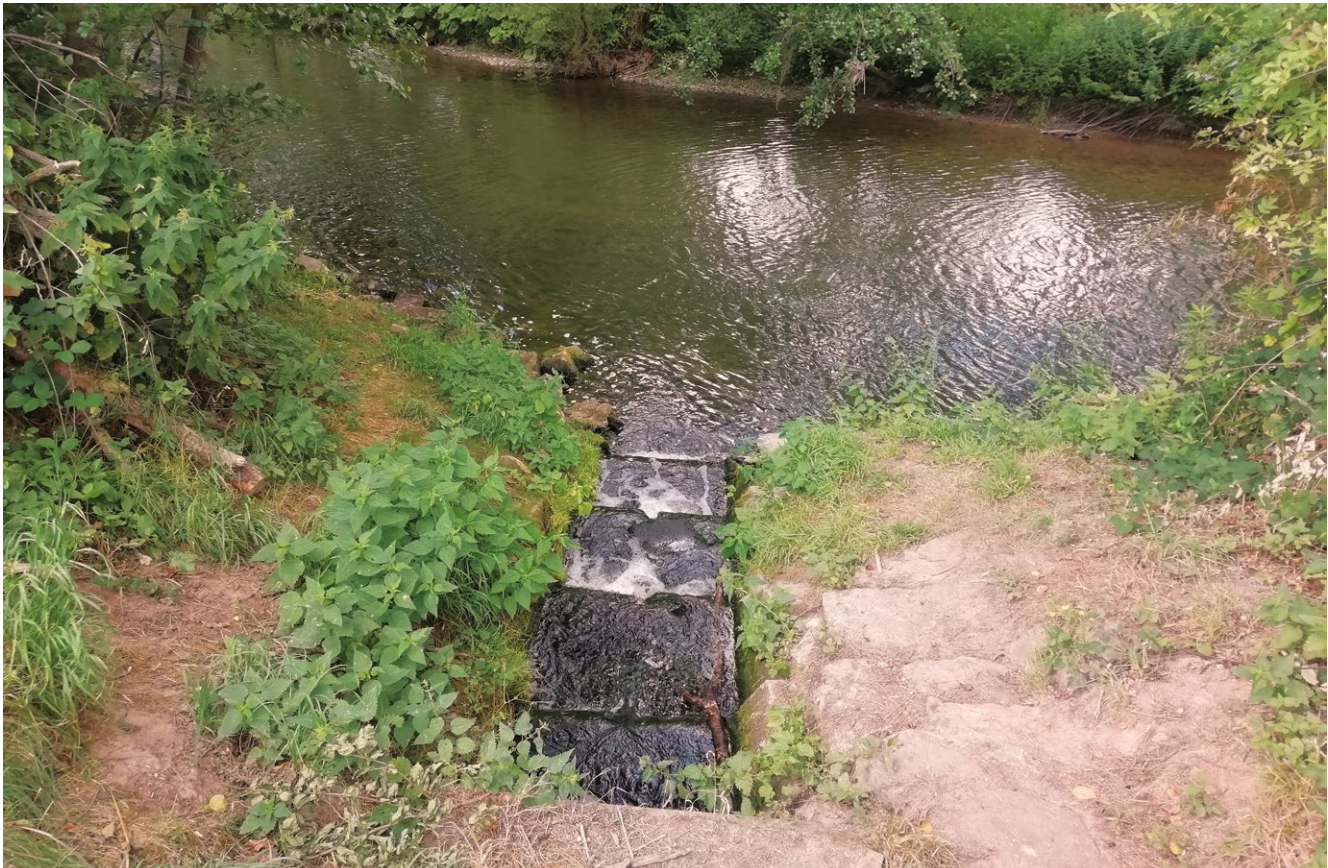
Einleitstelle der Kläranlage Schieder-Schwallenberg in die Emmer
