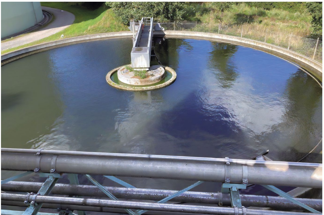
Rundes Nachklärbecken der Firma Pfeifer und Langen
