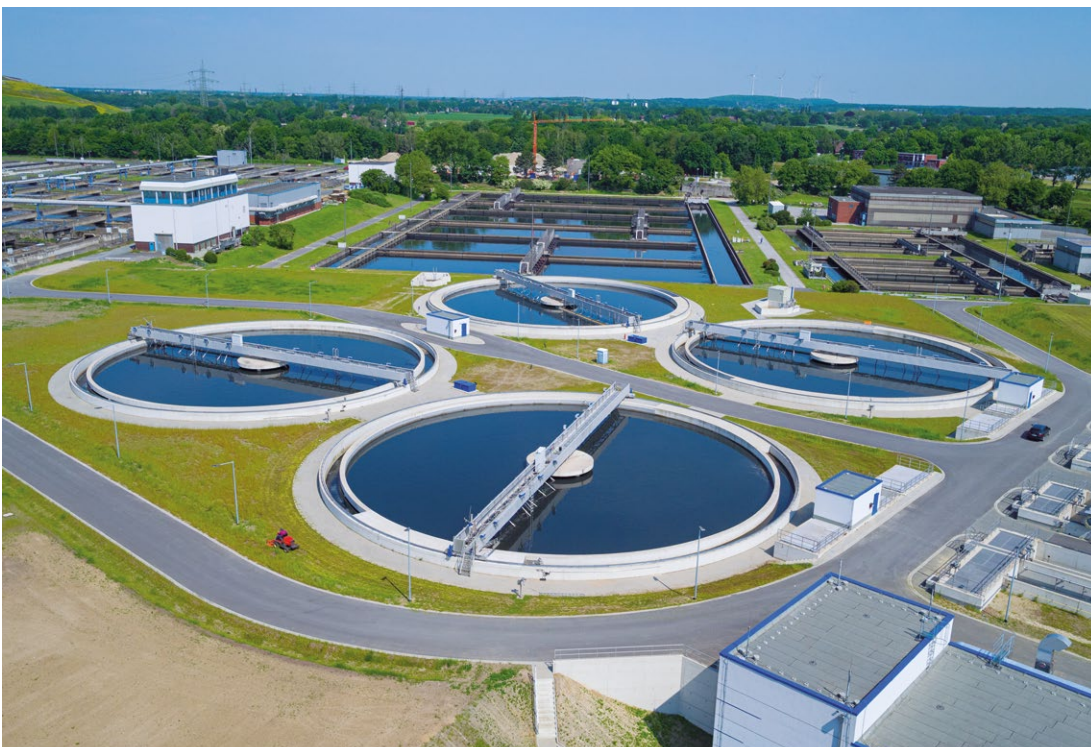
Vier Rundklärbecken der Kläranlage Emscher-Mündung in Dinslaken
