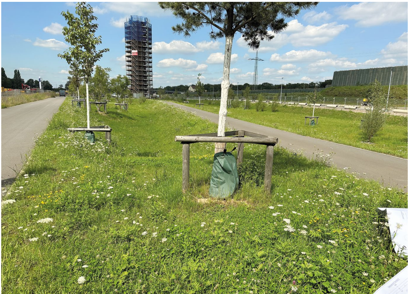
Versickerungsmulde im Neubaugebiet „6-Seen-Wedau“ im Süden von Duisburg
