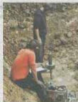
Natwendig: Sondierungsbohrungen im „Wackelpudding“ des Kraters.
