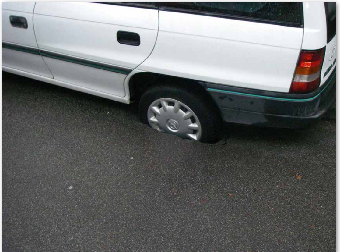
Bild 40: Straßeneinbruch im öffentlichen Verkehrsraum mit Beteiligung eines Kraftfahrzeuges, Foto 1 [Foto: Stadt Hamm]
