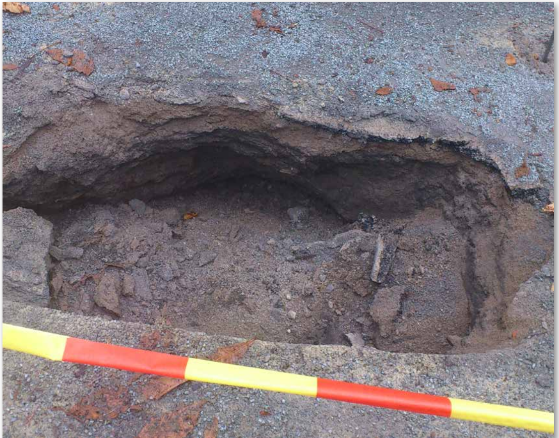
Bild 72: Detailansicht zu Bild 66 [Foto: Lobbe Entsorgung West GmbH & Co KG]
