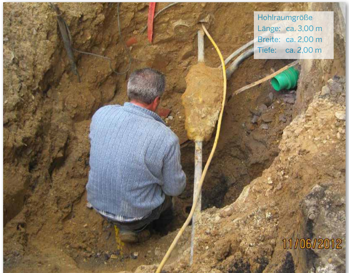
Bild 53: Freigelegter Hohlraum in der Friesenstraße [Foto: Technische Betriebe Solingen]
