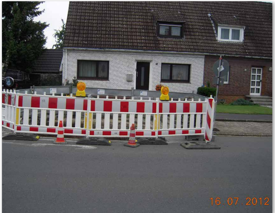
Bild 13: Baustelle an einem Straßeneinbruch im Dortmunder Stadtgebiet [Foto: Stadt Dortmund]
