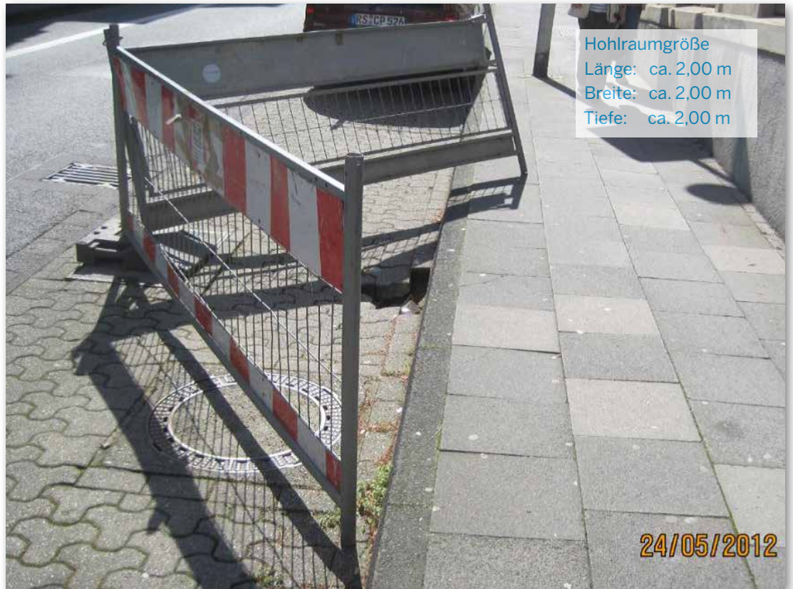
Bild 54: Straßeneinbruch mit unterirdischem Hohlraum in der Blumenstraße [Foto: Technische Betriebe Solingen]
