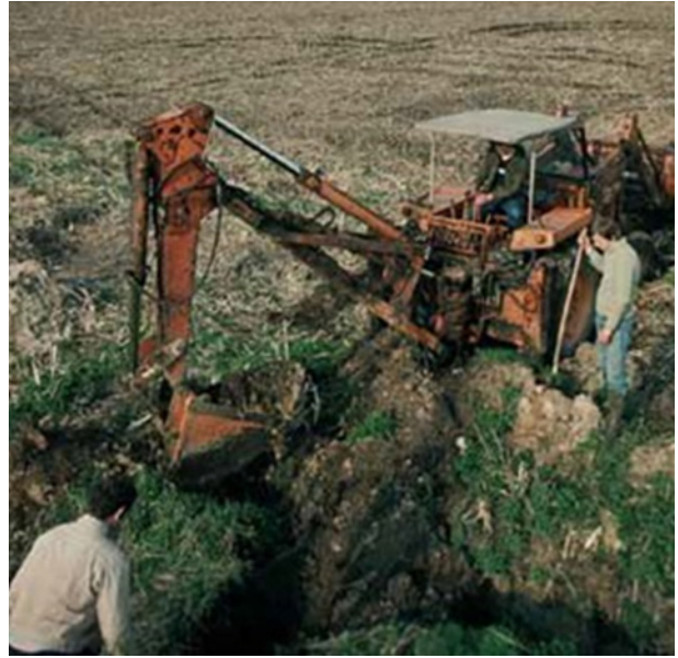
Abbildung 83: Ausbaggern der etwa 1,3 m tiefen und alle 4-6 m verlegten Drainagerohre (hier 1980) Foto: Archiv Biol. Station Rieselfelder Münster
