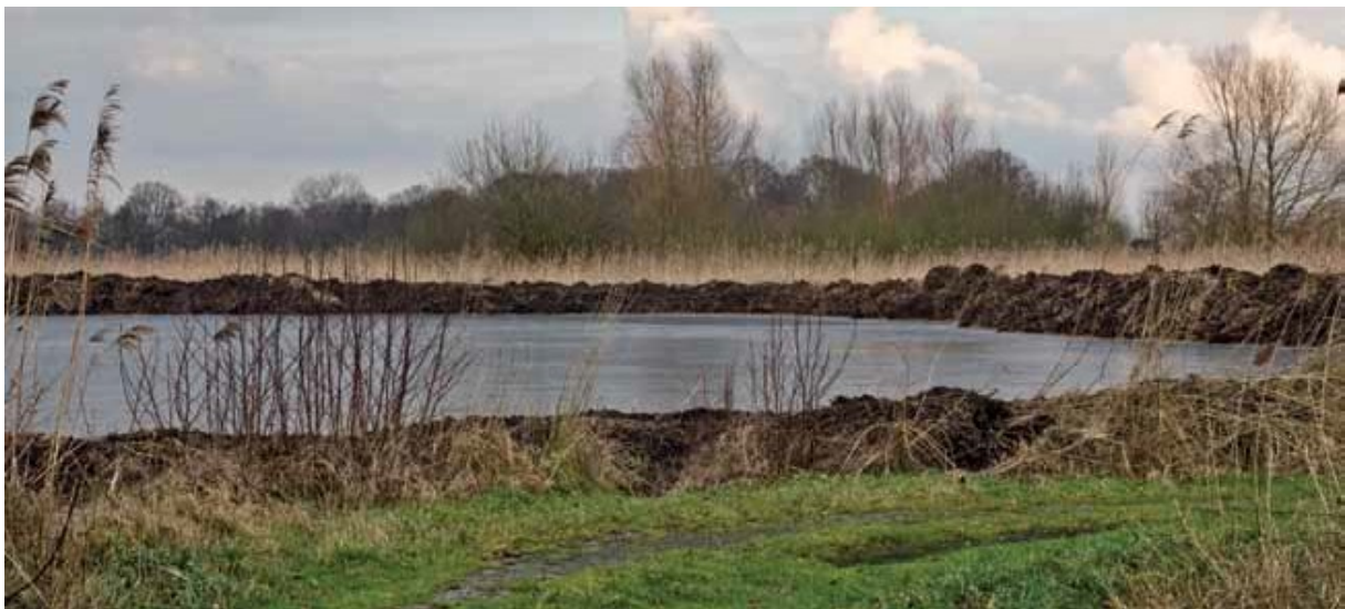
Abbildung 84: Schaffung von Stillgewässern durch Ablage der abgeschobenen Erdmassen zur Dammverstärkung Foto: Archiv Biol. Station Rieselfelder Münster
