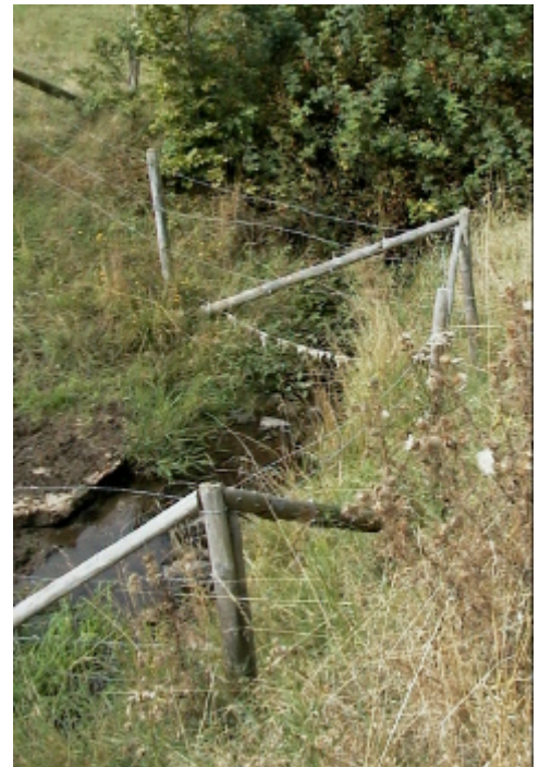
Foto 8: Viehtränkestelle an der Kläranlage Loch
