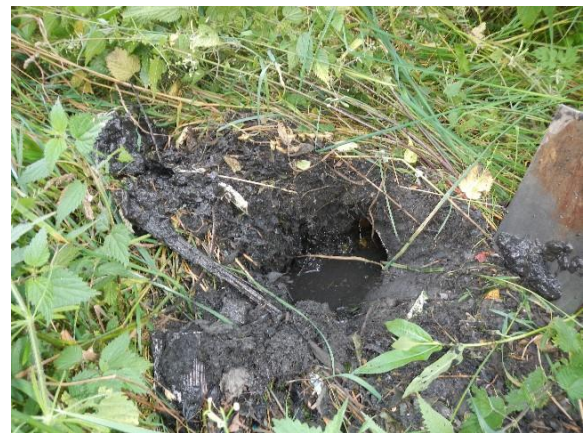
Abbildung 4: Zulauffrinne und Muldeneinlaufbereich mit Sedimentablagerungen (links) und durch Ablagerungen zugesetztes Einlaufrohr (rechts)
