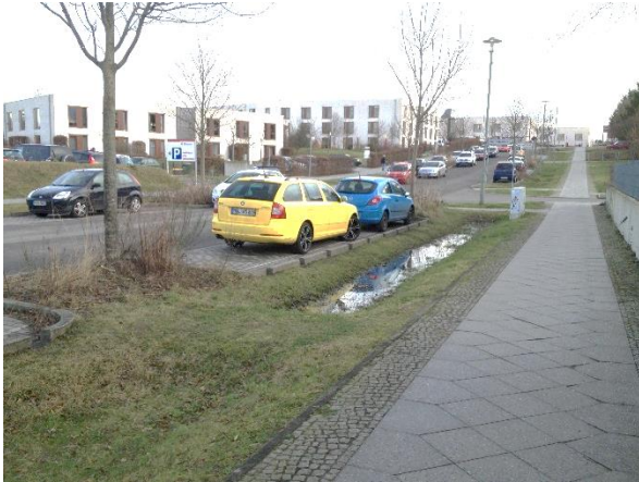
Abbildung 3: Hydraulisch überlastete Mulde im Tiefpunkt (links) und Kolmation und langanhaltende Wasserstände als Folge von Verschattung und Nicht-Beräumen des Laubes
