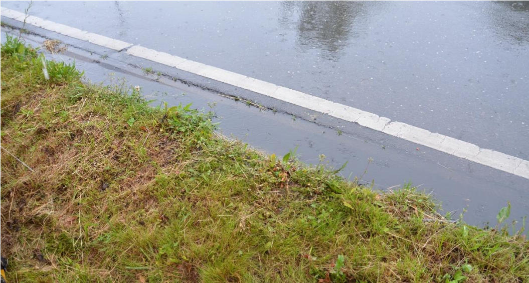
Abbildung 6: Verhinderung des Zulaufs in die Mulde durch Aufhöhung der Grasnarbe
