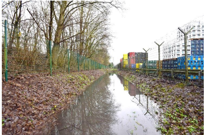
Abbildung 3: Hydraulisch überlastete Mulde im Tiefpunkt (links) und Kolmation und langanhaltende Wasserstände als Folge von Verschattung und Nicht-Beräumen des Laubes
