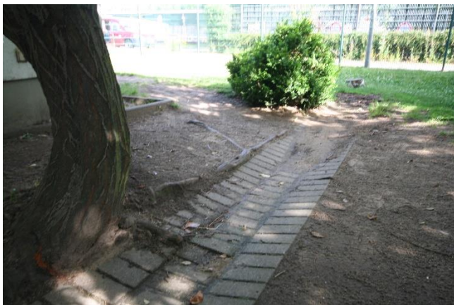
Abbildung 4: Zulauffrinne und Muldeneinlaufbereich mit Sedimentablagerungen (links) und durch Ablagerungen zugesetztes Einlaufrohr (rechts)
