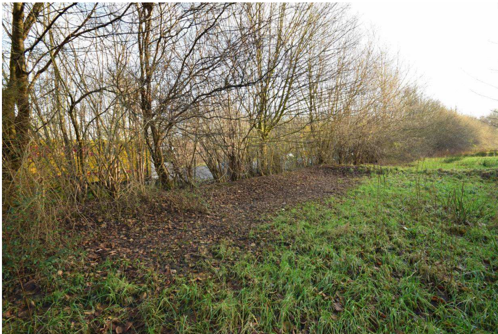
Abbildung 98: Ausfall Vegetation Muldensohle und -wall wegen Gehölzaufwuchs (Verschattung und Laubfall)
