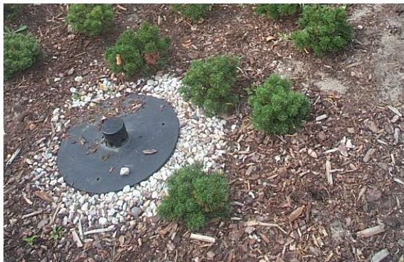
Abbildung 79: Muldenüberlauf mit Tauchwandprinzip zur Verhinderung des Eintrages Schwimm- und Feinstoffen in die Rigole
