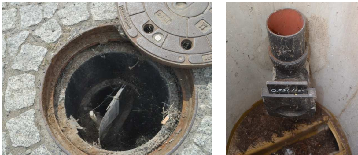
Abbildung 81: links: Kegeldrossel, rechts: Lochblendendrossel
