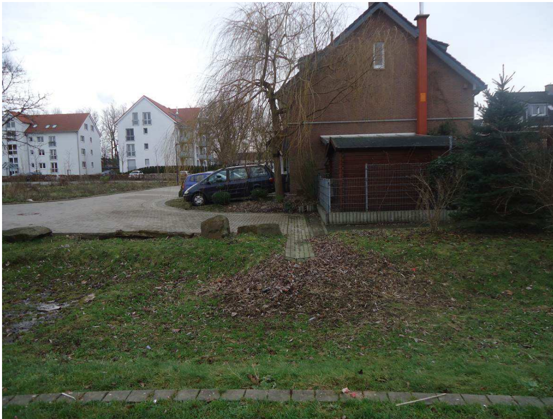
Abbildung 60: Aufhöhung um Muldeneinlaufbereich durch eingetragenes Laub
