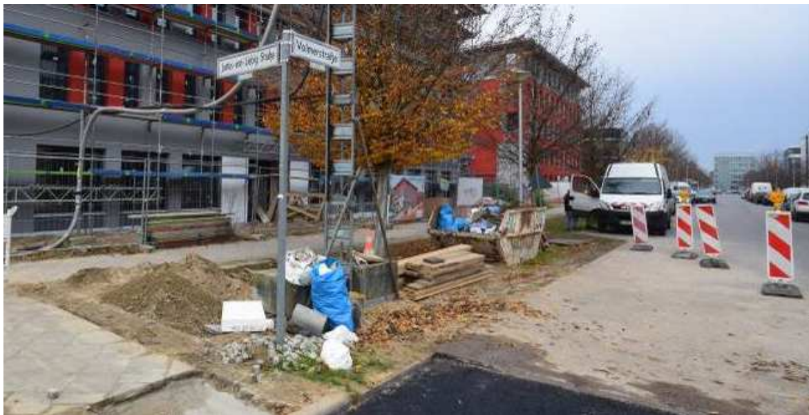
Abbildung 41: Baustelleneinrichtung in Versickerungsmulde, Anlage 7
