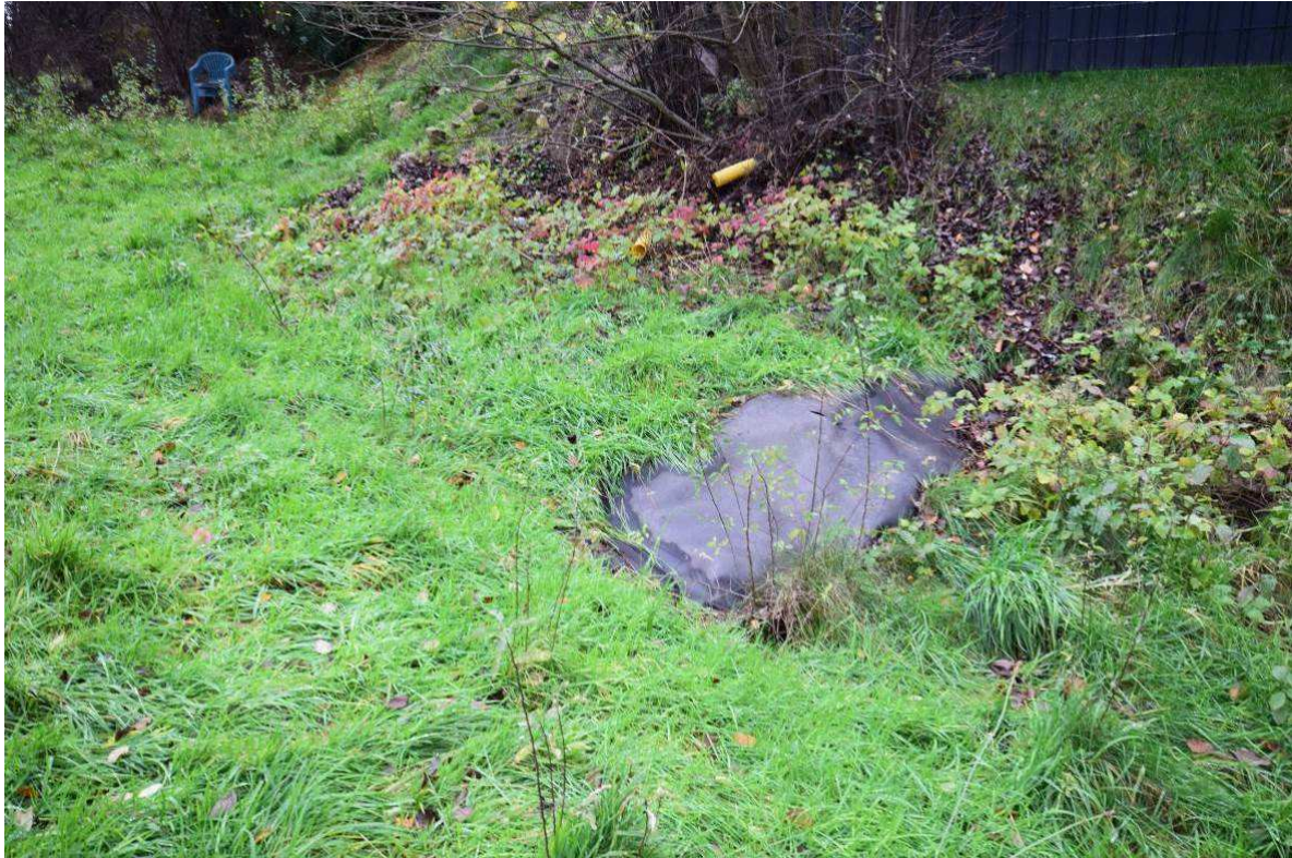
Abbildung 76: Erosierte Muldenwälle
