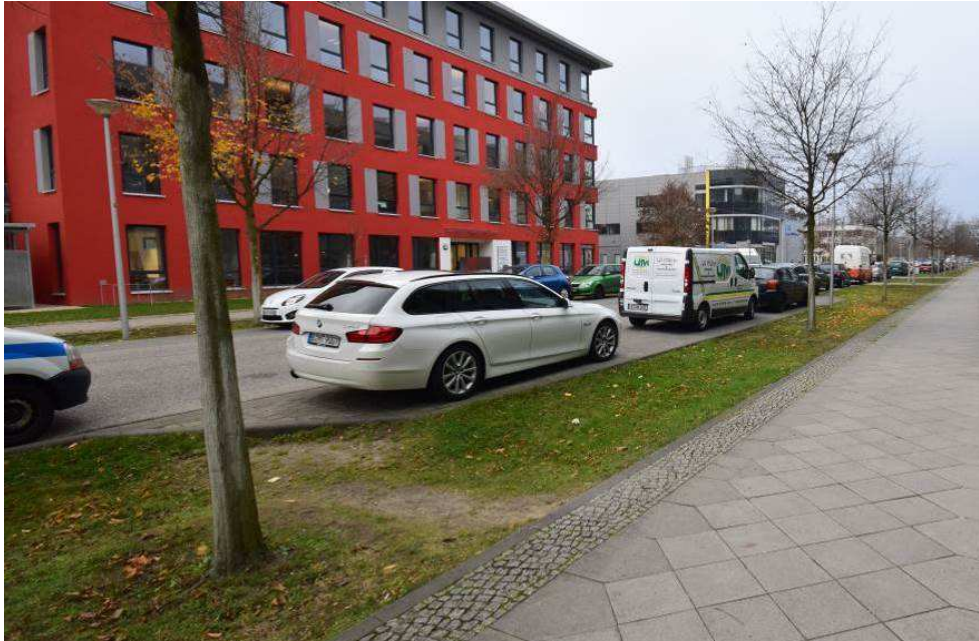
Abbildung 42: Trampelpfad in Versickerungsmulde zum Erreichen des Hauseingangs, Anlage 7
