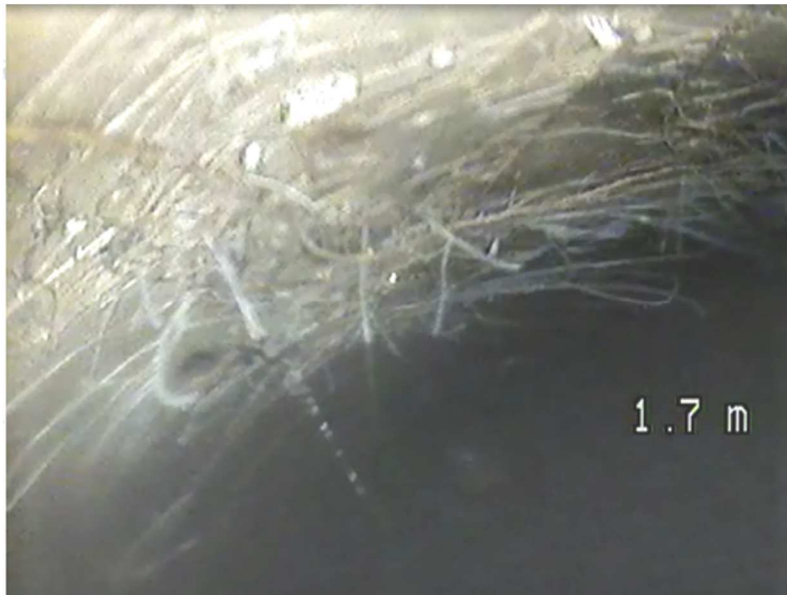
Abbildung 82: Dränrohr mit Feinwurzeleinwüchsen
