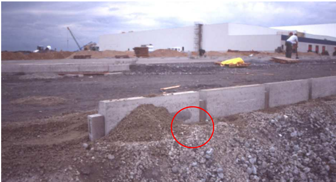
Abbildung 66: Einbau Betonpflasterstein zwischen Hochborden
