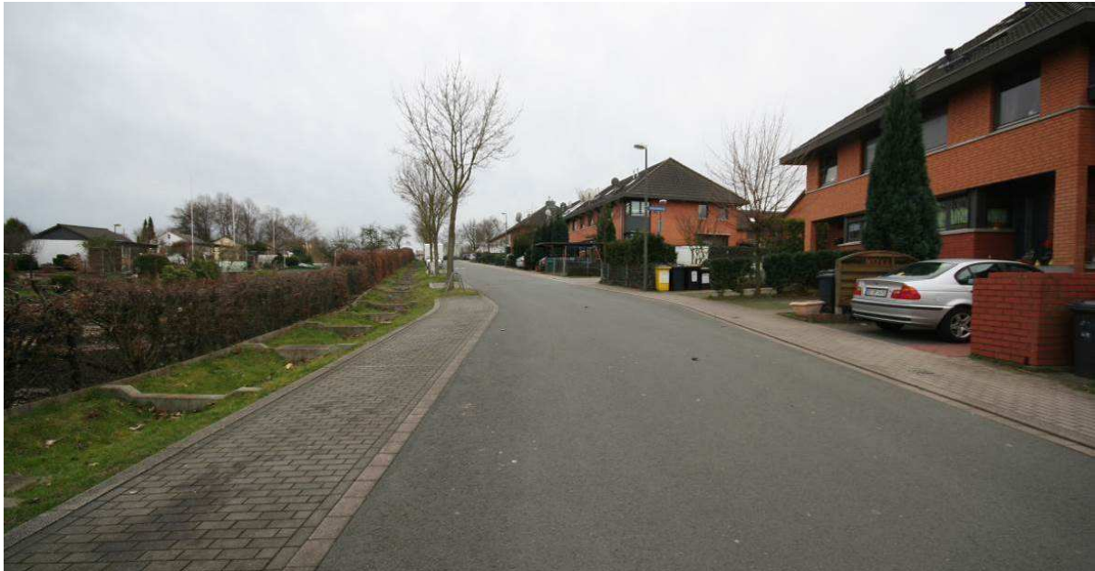
Abbildung 101: Straßenbegleitende Muldenkaskade, Anlage 13
