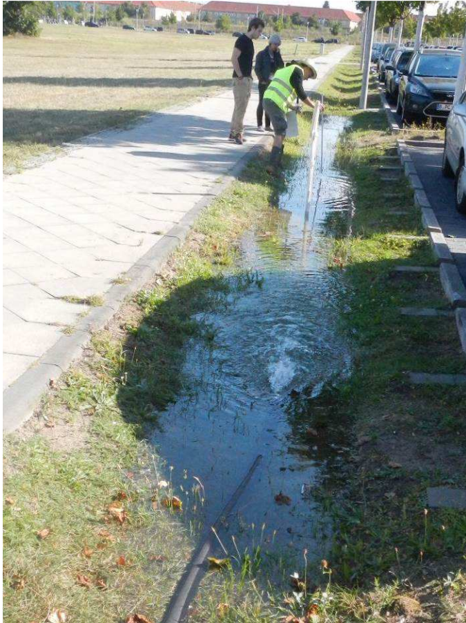
Abbildung 7: Flutung der nördlichen Mulde am Standort Nr. 6
