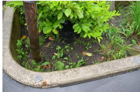
Abbildung 79: Muldenüberlauf mit Tauchwandprinzip zur Verhinderung des Eintrages Schwimm- und Feinstoffen in die Rigole
