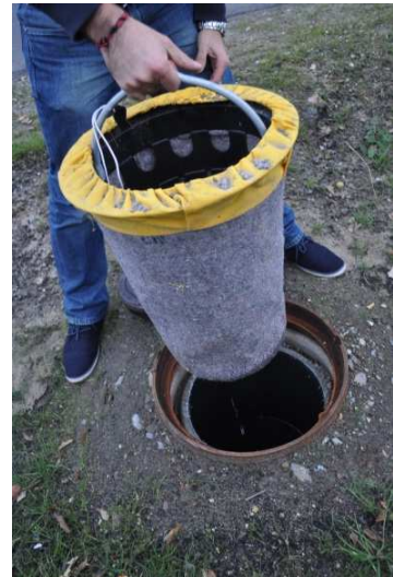
Abbildung 78: Muldenüberlauf (Aufsicht) mit gepflasterter Umrahmung, Vlieseinsatz zur Verhinderung des Eintrages von Feinstoffen in die Rigole
