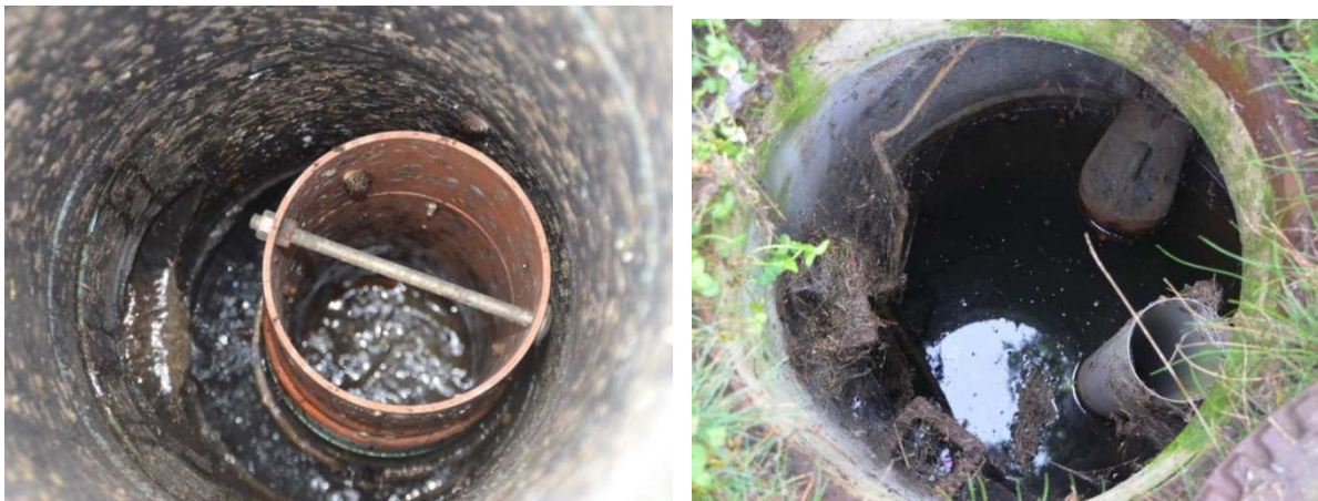
Abbildung 80: links: Erste Drossel mit verdrehenden Rohren, rechts: Drossel im Überlaufschacht im Ablauf des Schachtes montiert
