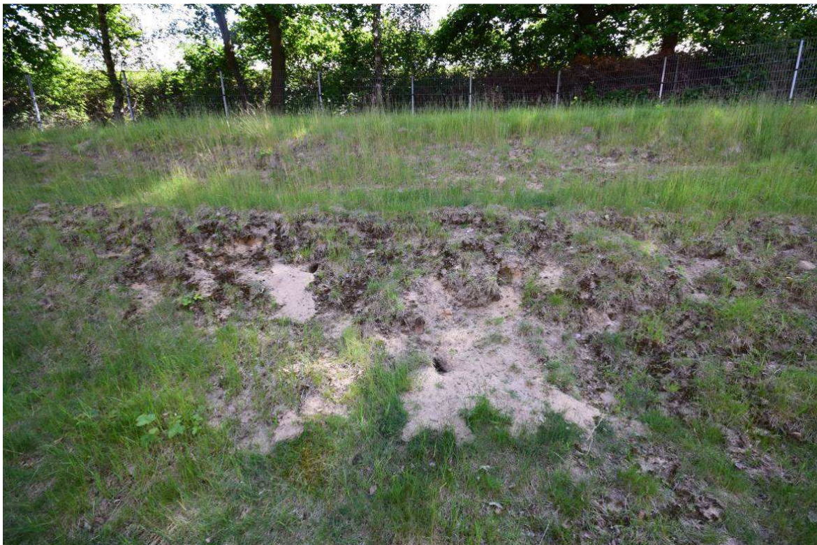
Abbildung 71: Erosionsschäden in Folge Wühltätigkeiten von Nagetieren
