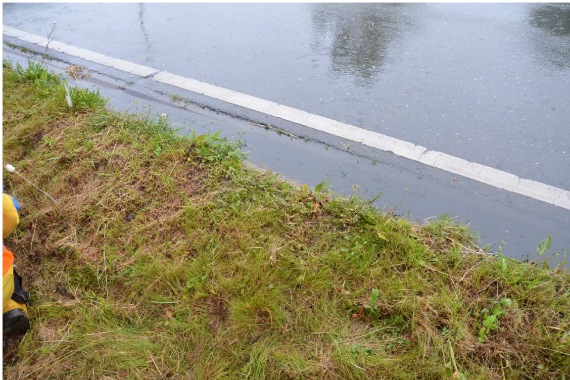
Abbildung 70: Punktueller Abschälung der Wulstbildung zur Vermeidung von Rückstau auf die Fahrbahn, Wulstbildung an Muldenzulaufsteinen mit Verhinderung des Einlaufens von Niederschlagswasser
